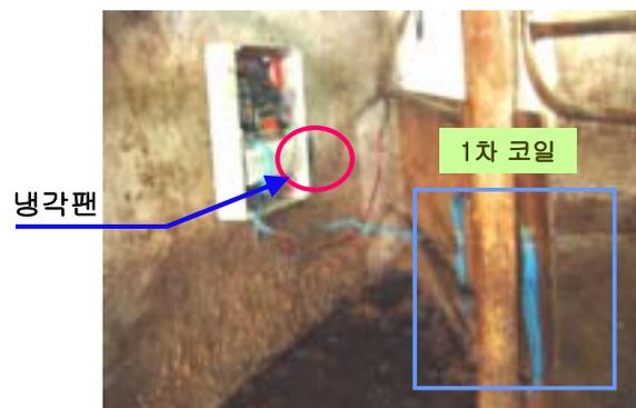
그림 3.1.38. 착유실의 E.I 장치 및 1차 코일 설치
