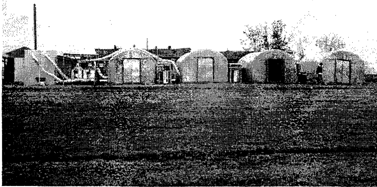
<그림 63> 시험재배사 설치 자동환경조절시스템(수원 입북동)
