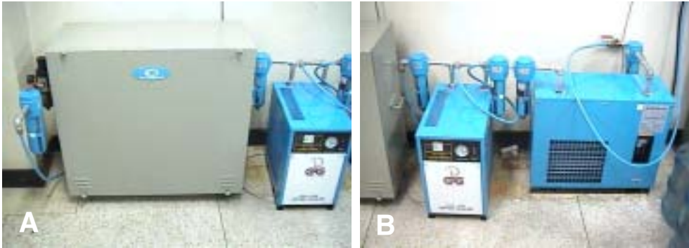
그림 15. 쪽파의 대량배양을 위해서 개발된 공기정화 장치. A ; 공기 발생기와 오일 등을 제거할 수 있는 필터시스템, B : 공기 발생기에서 나오는 더운공기를 차갑게 하는 cooler 시스템과 dryer 및 filter system.
