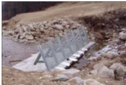
그림 2.3.30 스크린 설치후의 모습
