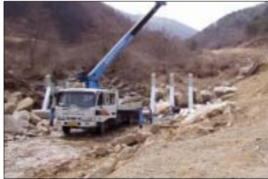
그림 2.3.29 크레인에 의한 설치모습
