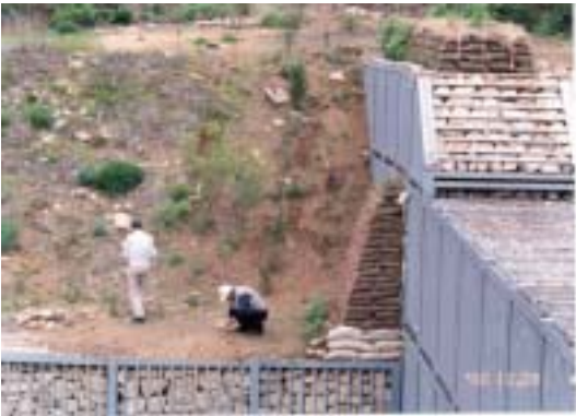
그림 3.2.18 댐둑마루 하단부 차폐수종 식재구 전경
