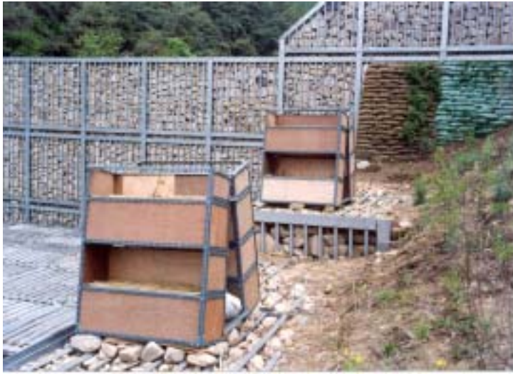
그림 3.2.16 벽면걸이 녹화시험 시험구 전경(보습재 시험구)
