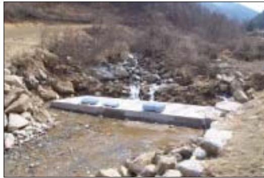
그림 2.3.28 기초콘크리트 및 앵커설치
