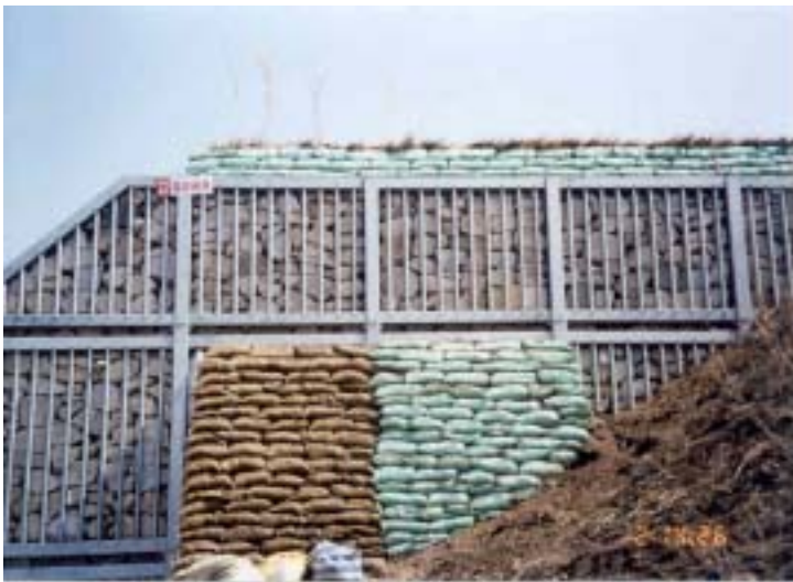
그림 3.2.13 그린마대공법 (I)(II)시공지 전경 (댐체사면전면)
