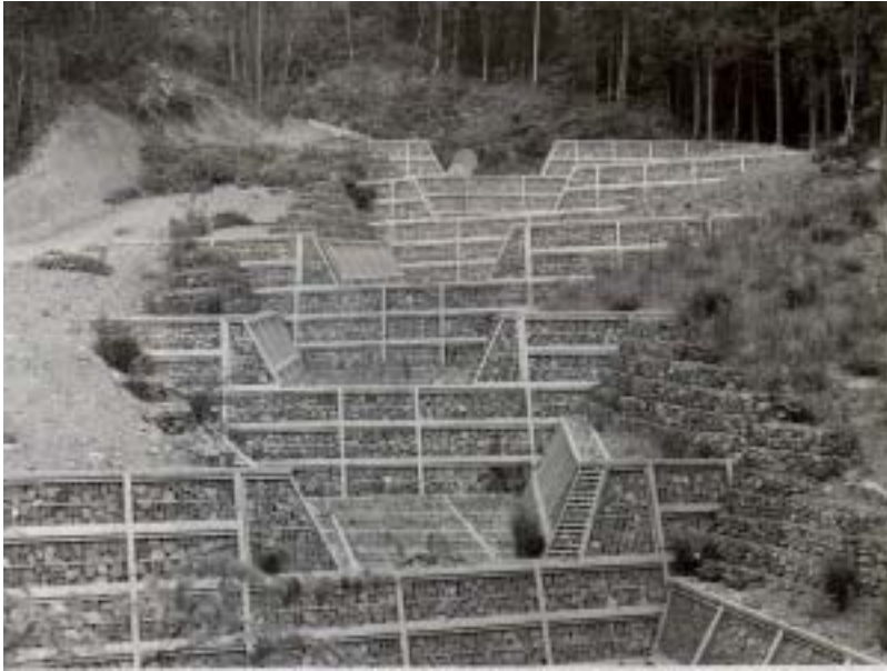
그림 2.1.4 강재틀댐이 사면활동 지역에 사용된 예
