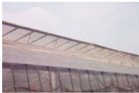
육종포 천창 및 측창 방충망 설치
