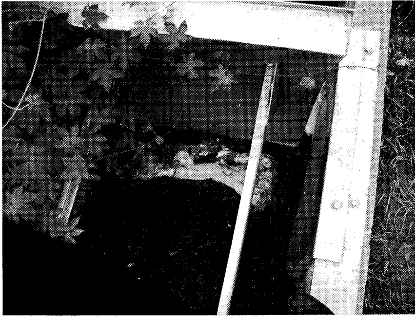
(b) 수문뒤에 오물이 축적된 모습 사진 3.1.12 오물이 축적된 모습
