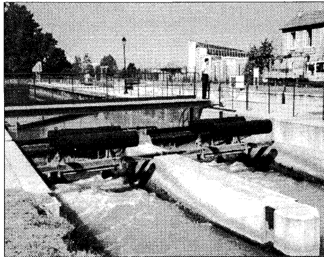
사진 2.1 프랑스 MOEX 지방에 설치된 AMIL GATE의 모습
