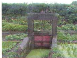
그림 3.2.18 분수문 고정을 위한 과대한 콘크리트 구조물 설치(설치비 증가요인)
