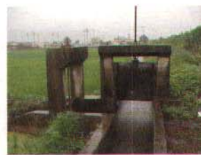
그림 3.2.18 분수문 고정을 위한 과대한 콘크리트 구조물 설치(설치비 증가요인)
