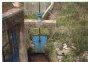
그림 3.2.18 분수문 고정을 위한 과대한 콘크리트 구조물 설치(설치비 증가요인)
