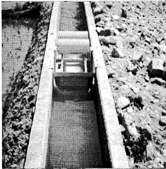
사진 3.1.17 무동력 자동 수문 설치 모습
