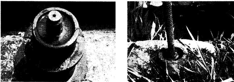
<개폐헨들 삼입부 물고임>
