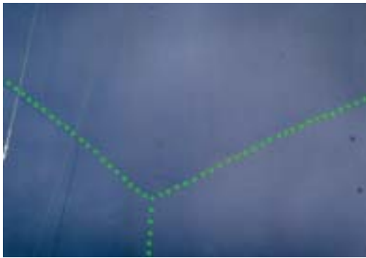
Fig. 61. Edge line of ceiling
