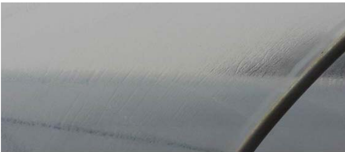
현장사진 3 : 5번 하우스 => 필름표면 유적상태가 지저분(지렁이 유적)함
