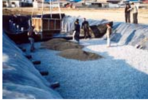
호기성조의 여재조립 시공전경
