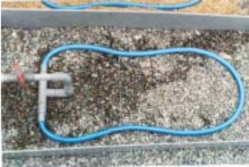
호기성조 분배관 설치공사
