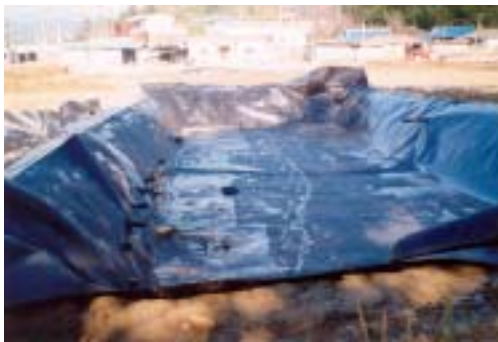
호기성조의 차수막 시공전경
