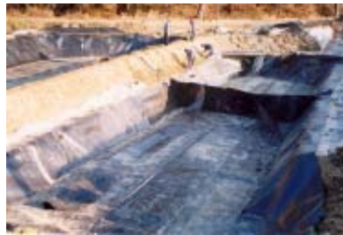
혐기성조의 차수막 시공전경
