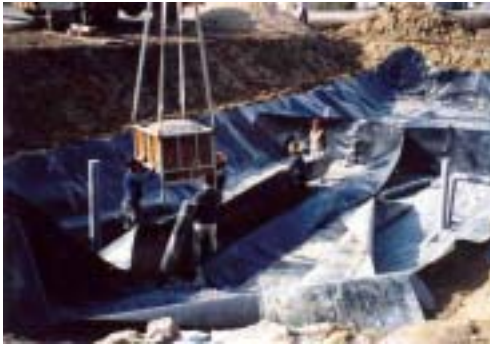
혐기성조의 자갈조립 시공전경
