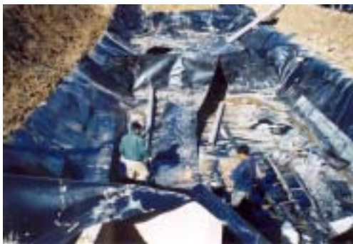
혐기성조의 배관공사 시공전경
