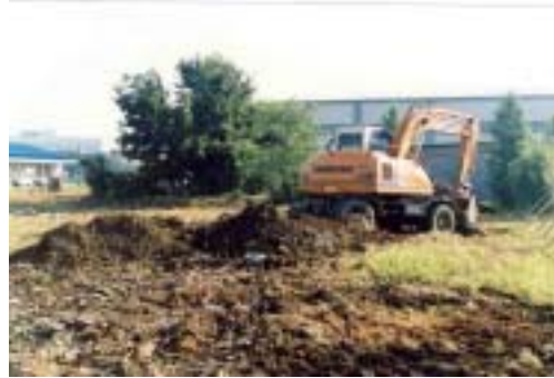
소형하수처리장의 터파기 공사
