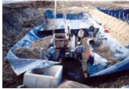
혐기성조의 여재조립 시공전경
