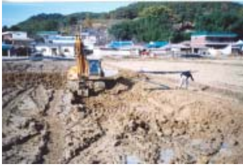
호기성조의 기초 터파기 시공전경
