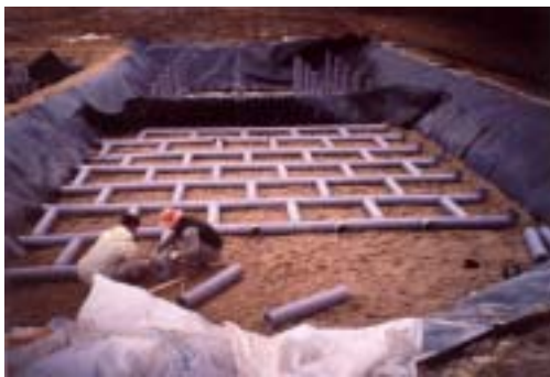
호기성조의 배관공사 시공전경
