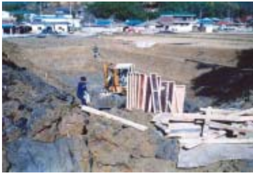
혐기성조의 집수조 시공전경
