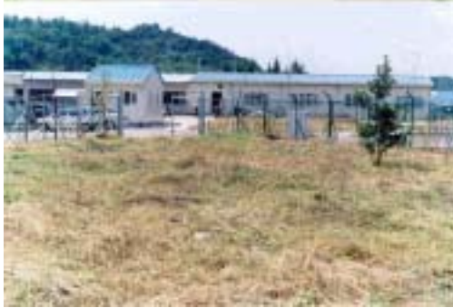
소형 하수처리 장치의 시공부지 전경
