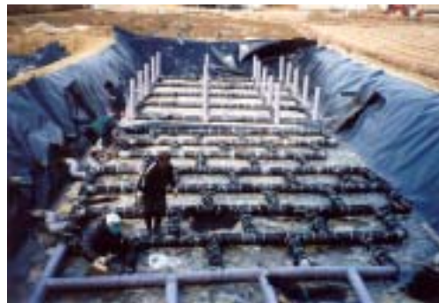
호기성조 중간통기관 시공전경
