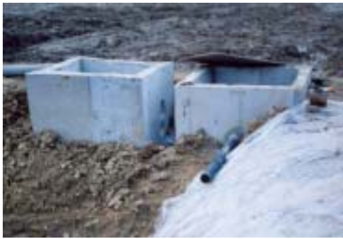
호기성조의 유량조정조 시공전경
