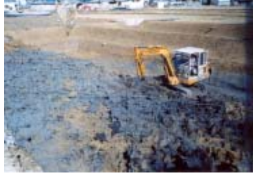
혐기성조의 기초 터파기 시공전경
