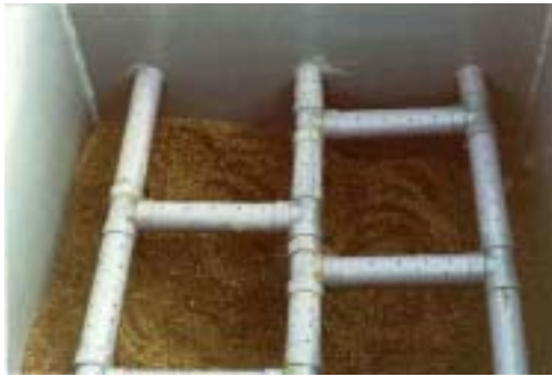
호기성조의 상부 통기관 공사
