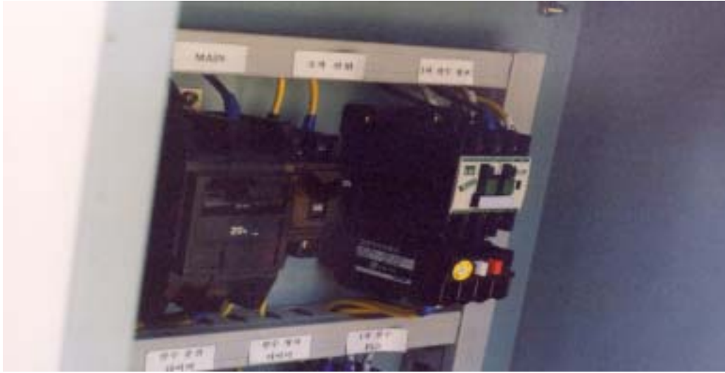
Fig. 4-6. MCC 설치
