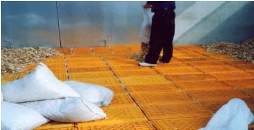
Fig. 4-3. 후처리 축산뇨오수 처리용 살수여상처리의 다공성 상자
