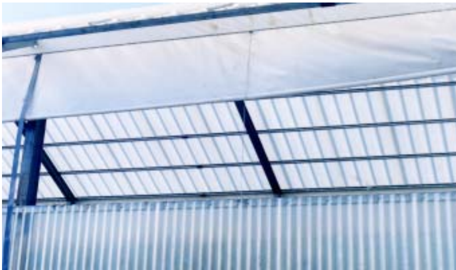
Fig. 4-27. 살수여상 처리조의 밀폐형 투명 하우스와 측창 개폐장치
