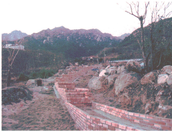
<부도 2-7> 향토길 조성 공사모습
