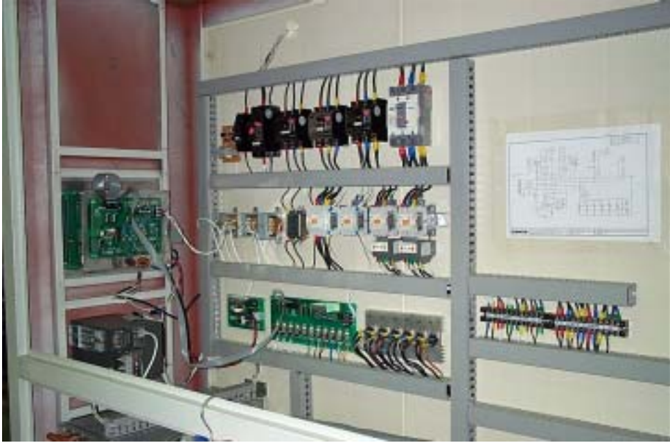
그림 12 온·습도 제어시스템 내부 배선 모습
