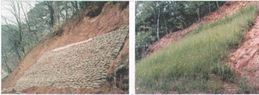
<그림 4> 녹화용 식생마대 공법의 적용 (시공전/시공후)
