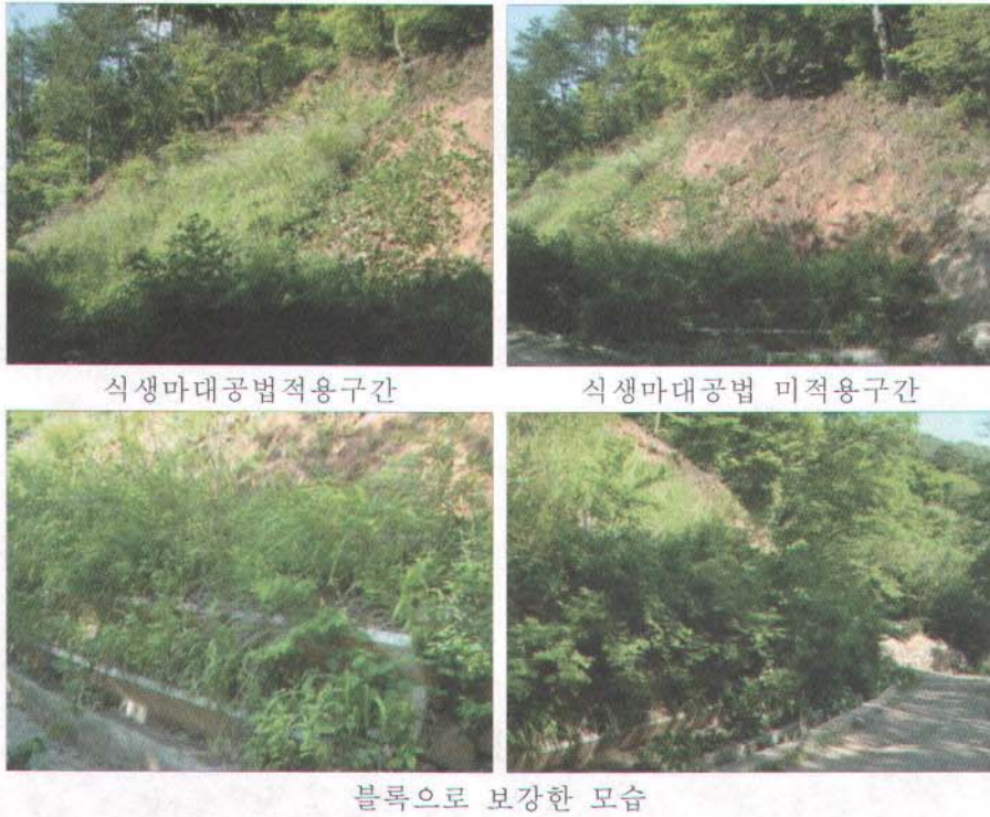
<그림 20> 식생마대공법 적용구간 및 미적용구간
