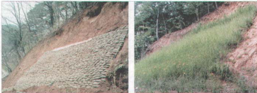
<그림 19> 녹화용 식생마대 공법의 적용 (시공전/시공후)
