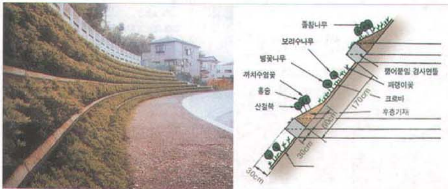
<그림 3> 콘크리트 틀을 이용한 비탈면 녹화공법의 시공사례 및 단면도
