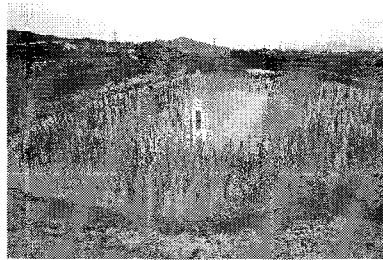
<사진 3-52> 인공습지 시스템 부들식재 후 모습
