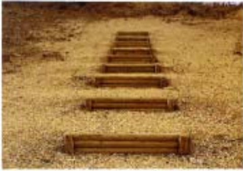
경사지에 설치된 목재계단
