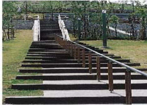
경사지 지면과의 경계가 자연스럽게 처리된 목재계단(日本 大阪市)
