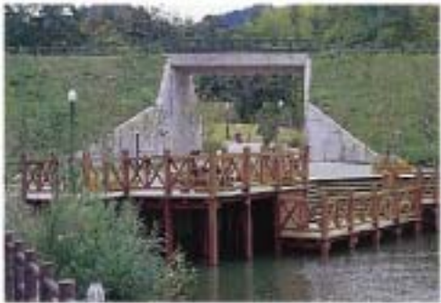
수변에 설치된 목재데크는 토목시설물의 삭막함을 완화시켜 준다(島根縣)
