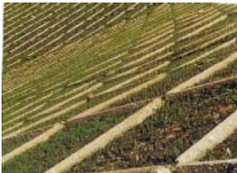
그림 7. 미가공 목재를 사용한 사면처리의 예
