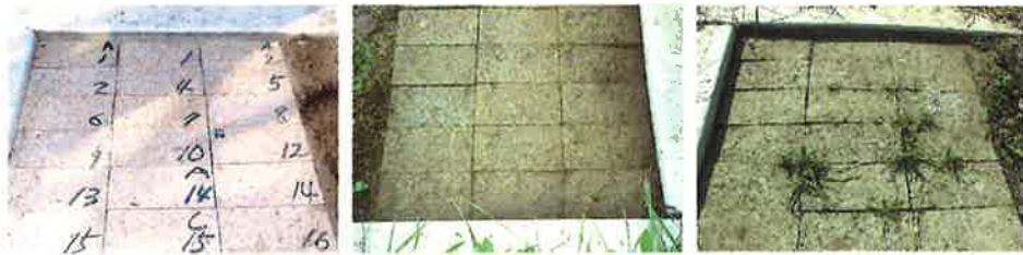
<사진 2-19> 야외에 설치된 목질·시멘트블럭(左 : 설치직후, 右 : 9개월 경과후)
