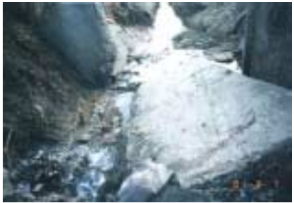
그림 4.4.1-1 파괴된 기존의 콘크리트 낙차공
