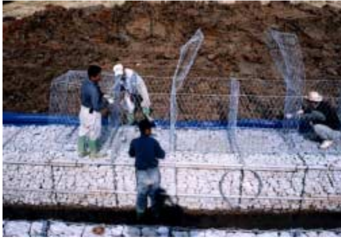
그림 4.3.2-10 좌안 1단 시공
