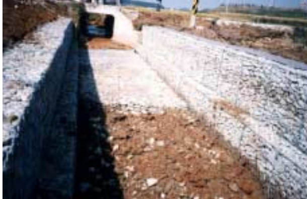
그림 4.3.2-12 완공된 돌망태 하천 제방
