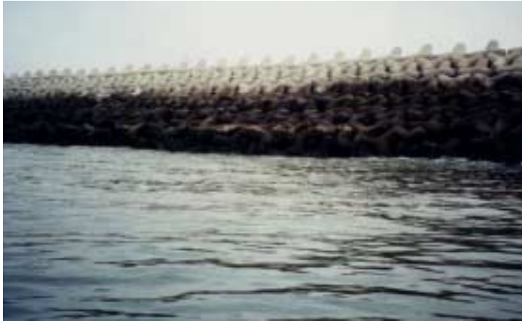
그림 3.5.3-1 T.T.P 설치사진
