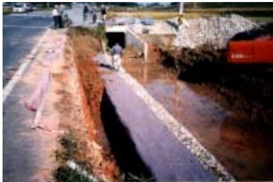
그림 4.3.2-8 우안 1단 시공
