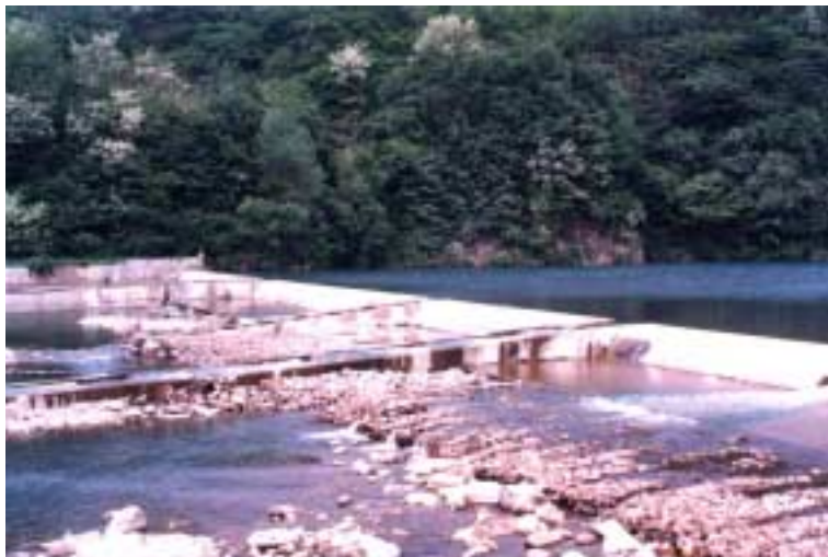
그림 2.2.1-1 돌망태를 이용한 에프론 및 어도
