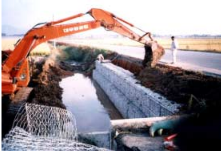
그림 4.3.2-9 우안 2단 시공
