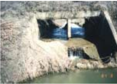
그림 4.4.1-1 파괴된 기존의 콘크리트 낙차공
