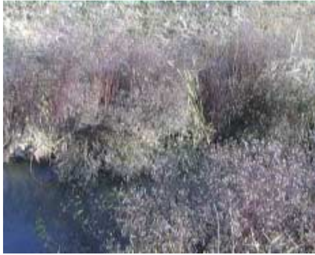
그림 2.2.2-2 돌망태 호안(공사 후 1년)
