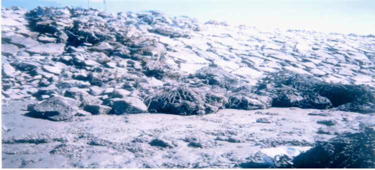
그림 5.3.2-1 화용방조제에 설치된 돌망태 상태
