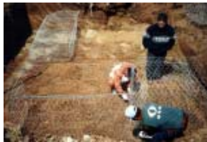
그림 4.4.4-8 돌망태 설치
