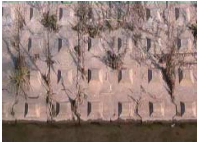
그림 2.2.2-1 콘크리트 호안(공사 후 7년)
