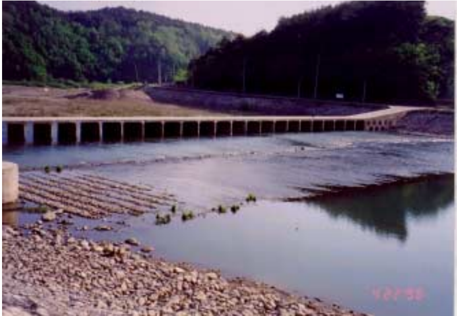
그림 2.2.1-3 돌망태를 이용한 바닥보호공
