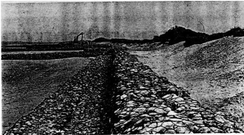
그림 2.3.1-1 Old Hunstanton, Norfolk에 설치된 돌망태 방사제(防砂堤)
