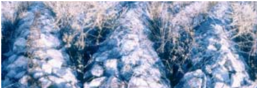
그림 5.3.1-1 석문방조제 상단에 설치된 돌망태 상태
