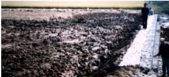
그림 4.3.2-11 좌안 2단 시공
