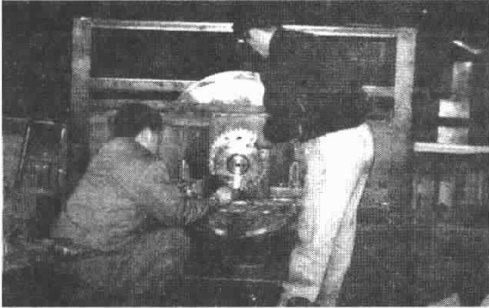
그림4-31 회전 테이블과 트랜스미션 조립 장면
