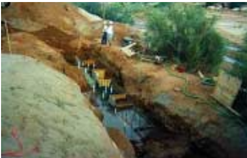
(다) ‘gate’와 관측정을 설치한 후 메운 장면
