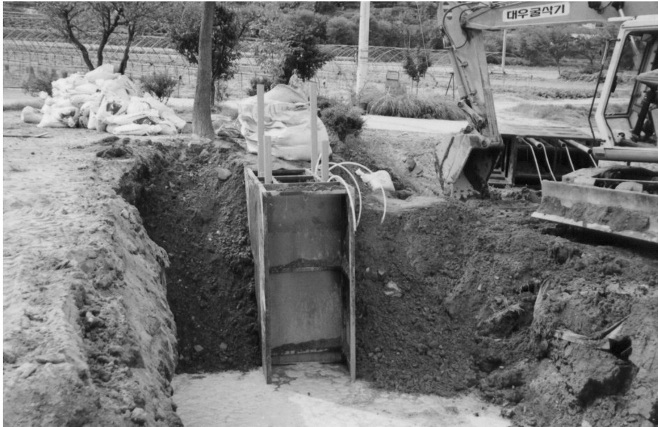
그림 3 트렌치에 삽입된 철재구조물 주변을 기존 토양으로 채우고 있는 장면
