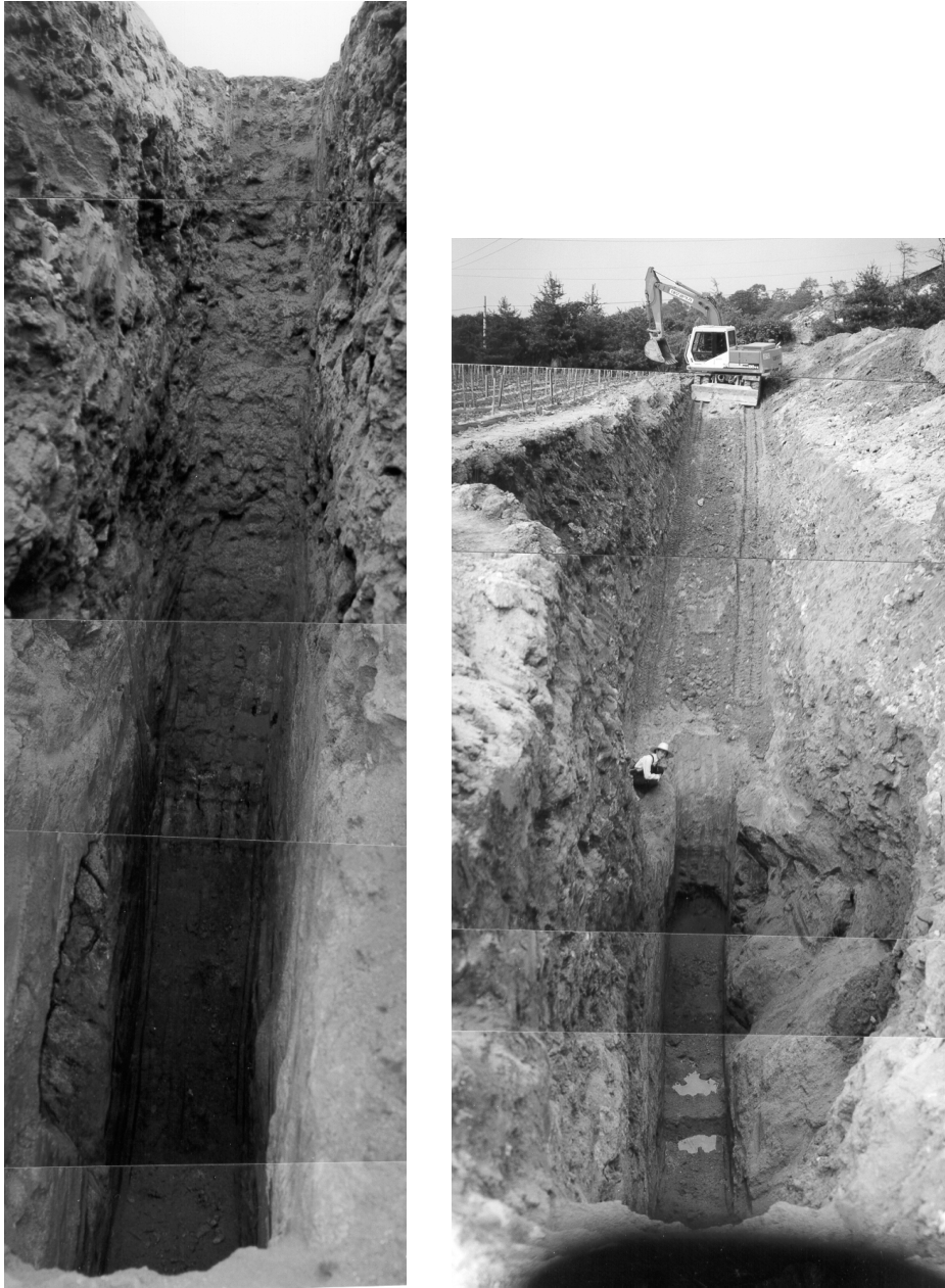
(가) 포크레인으로 트렌치(심도 8.8m) 굴착 <그림 3-1-18> A지역 투수성반응벽체 설치 현장
