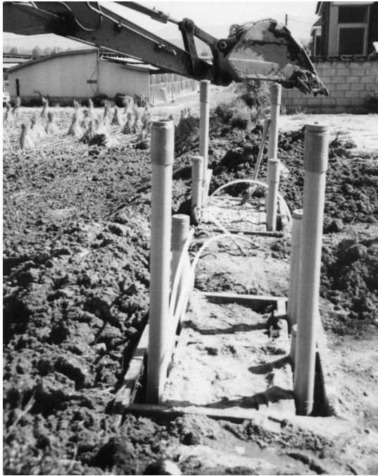
그림 7 투수성반응벽체 상부를 기존 토양으로 되메운 현장
