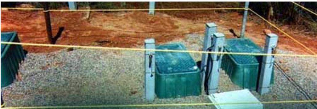
(마) 시공을 완전히 마친 상태에서의 관측정 및 반응벽체
