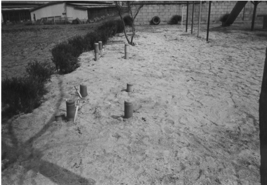
그림 9 설치 완료 후 현장 정리된 장면
