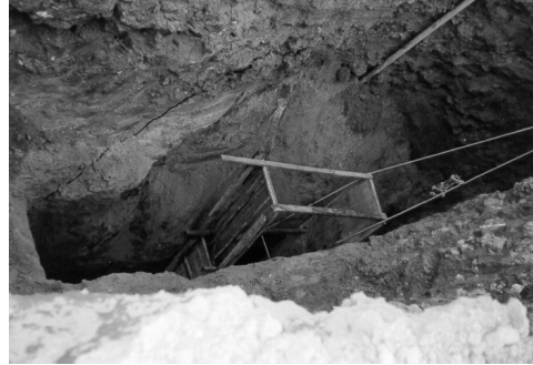
(다) 트렌치 내부에 목재 지지대 설치
