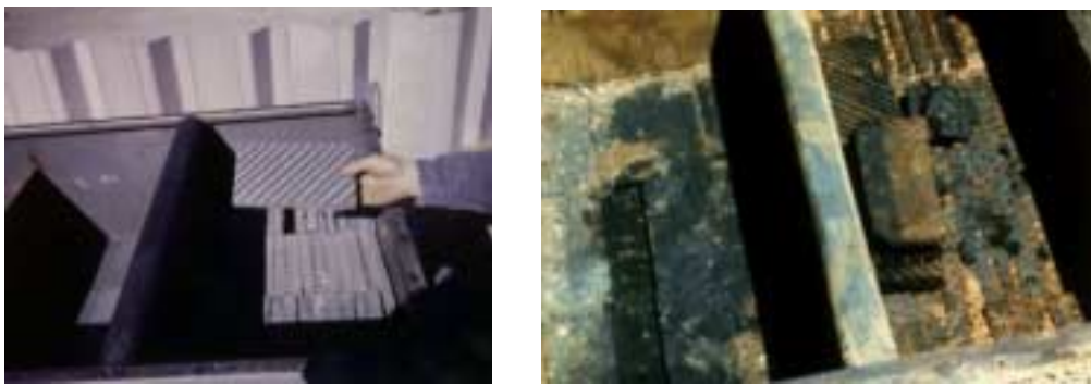
<그림 2-3-20> 미국 콜로라도주에 설치한 투수성반응벽체의 반응물질로 사용한 거품형태의 Fe(0) 블럭 사진 (Permeable Reactive Barriers, 2000) (가) 투수성반응벽체 설치당시, (나) 가동 2년 후의 상태
