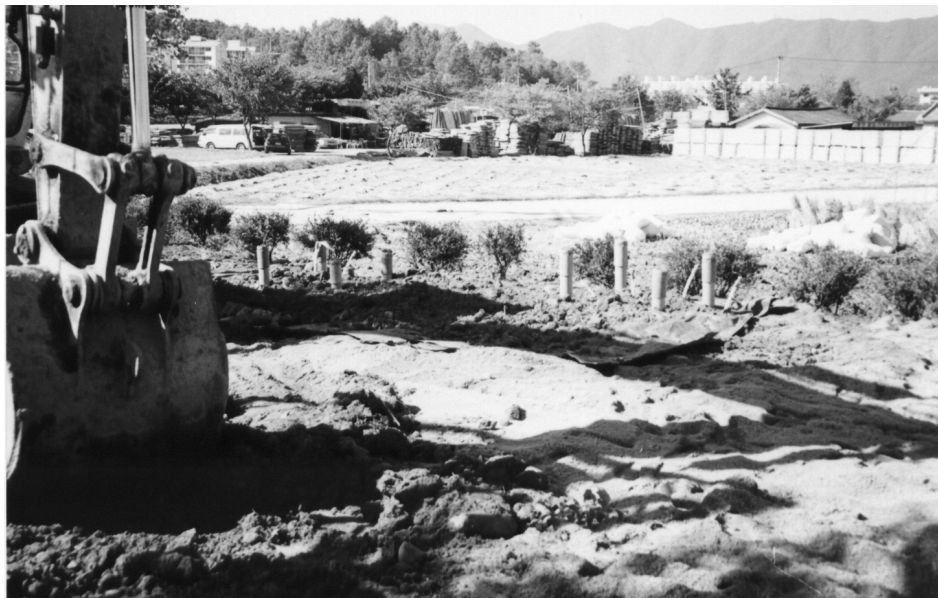
그림 8 투수성반응벽체 최상부에 천막을 덮은 후 모래로 덮고 있는 장면
