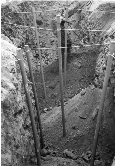
(라) 관측정 설치 후 되메움
