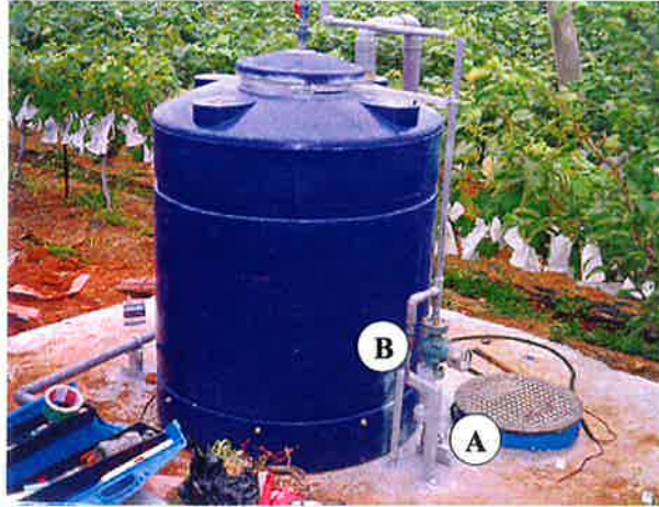
<그림 5.11> 흡수성바이오필터 유량조정조 설치
