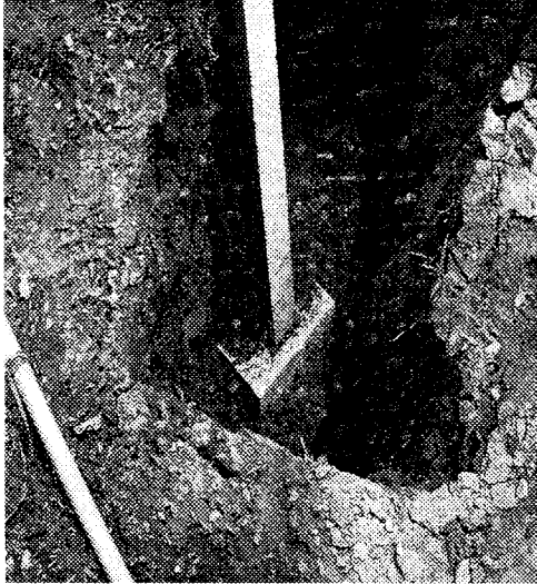
사진 2-8. 가장자리지주나 버팀대의 경우 아래로 내려앉거나 밀리지 않도록 받침판을 대도록 한다.
