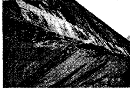
b. 슬래브 손상(백화, 박락, 골재 탈락 등) (1)
