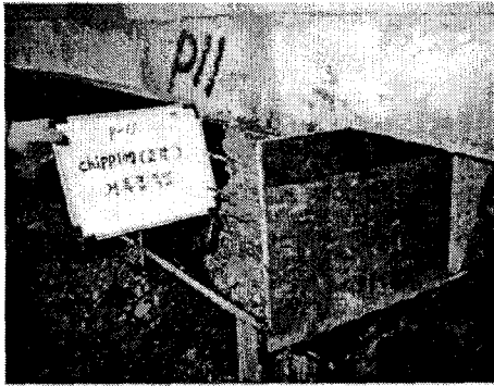
c. 교각 거푸집 시공
