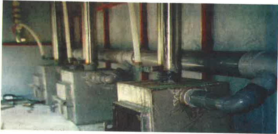
그림 3-3. 가스응축장치의 가스 냉각부 사진
