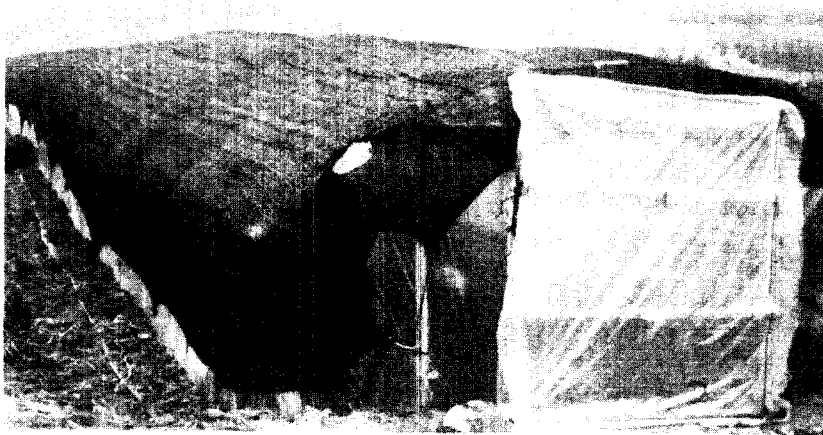
Fig. 1-2. 고밀도 폴리에틸렌(HDPE)를 사용한 직사광선막이 덮개
