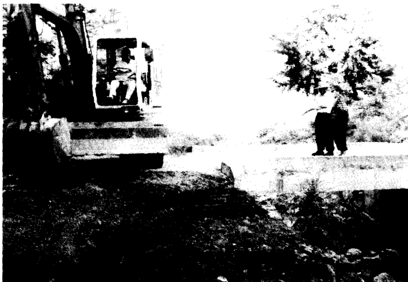
Fig. A-6. 시험포장 보조기층 시공 1
