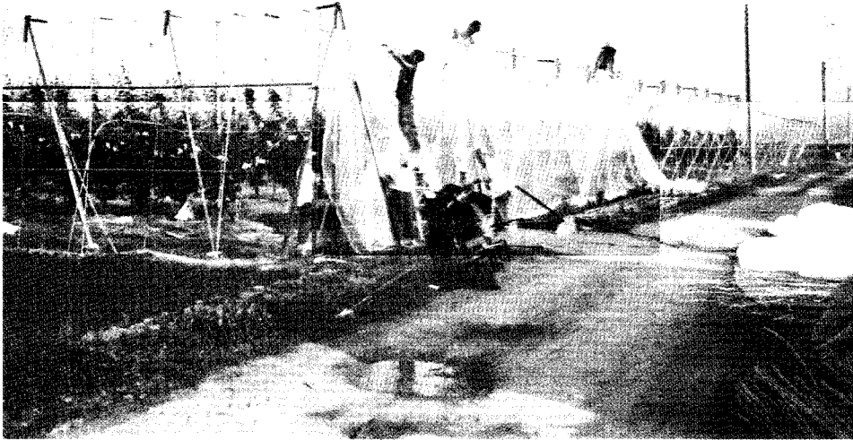
사진 8. 측면 방충망 설치
