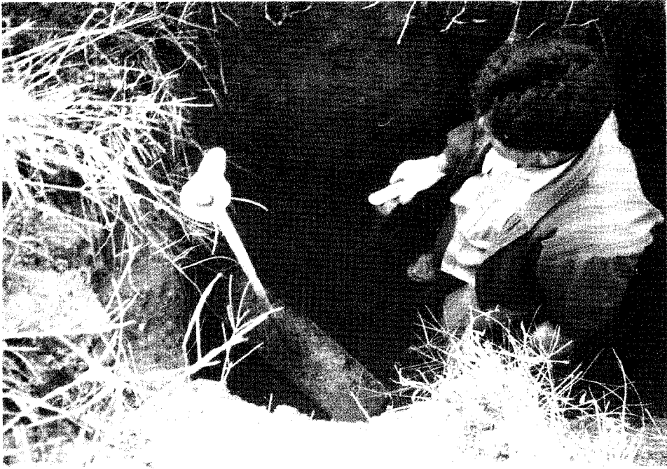
사진 3. 당김돌 설치
