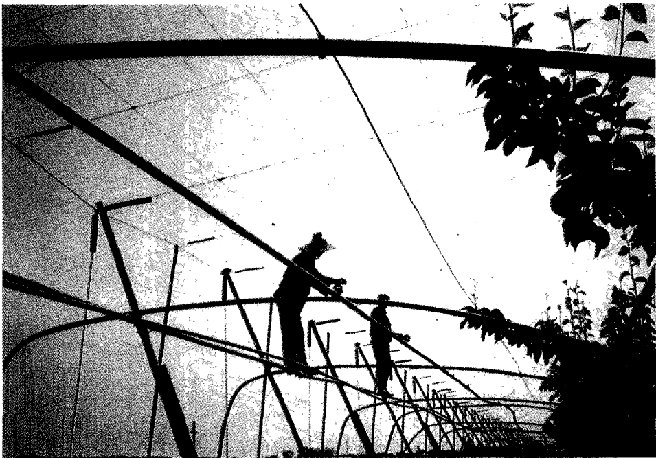
사진 8. 방충망 골격 설치 마무리 (전선관 피복, 철사 결속)
