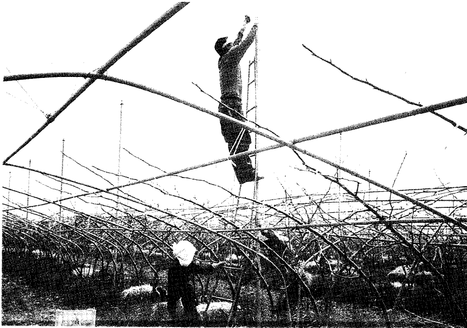
사진 7. 안테나형 기둥 설치
