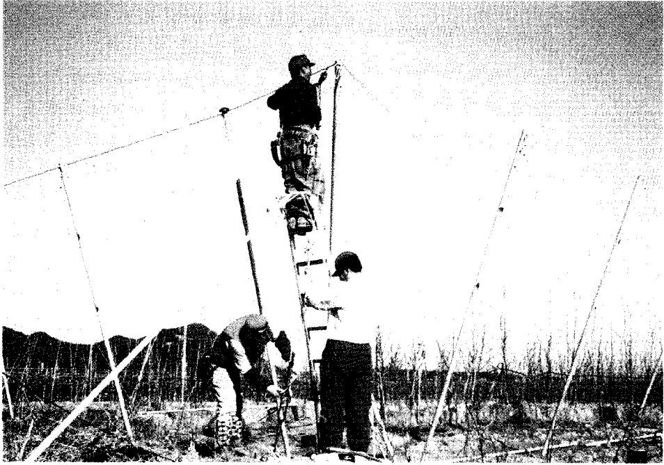
사진 6. 상단 와이어선 설치
