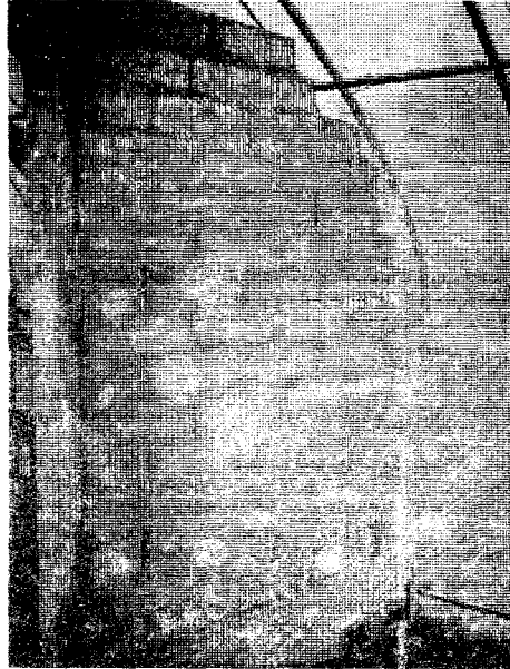
그림 4-20 완성한 흙벽돌 조적 모습
