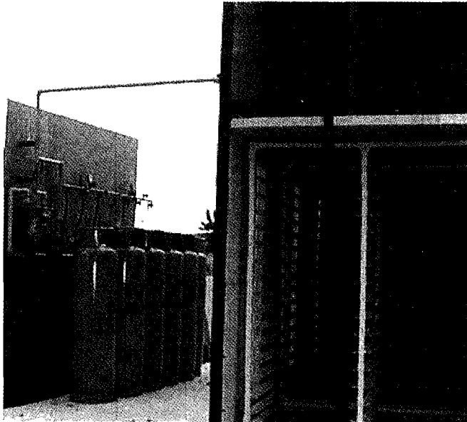
그림 3-45 LPG 연료 공급 장치
