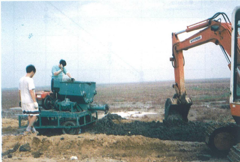
사진 5.6 고탐수비 흙시멘트의 차량주행가능성 확인을 위한 시험포 설치
