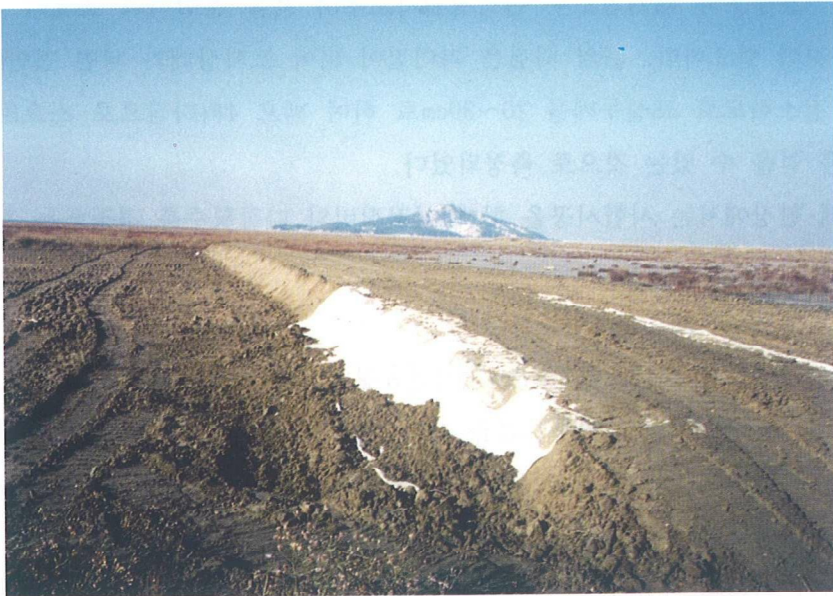
사진 부 1.4 간척지 표층토 대기건조공법 성토후 전경
