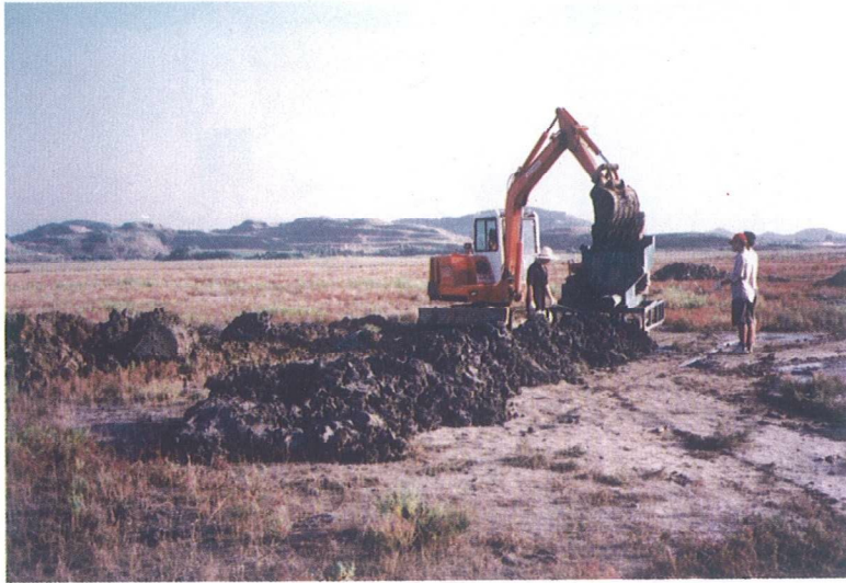
사진 5.3 시멘트 혼합처리 장면
