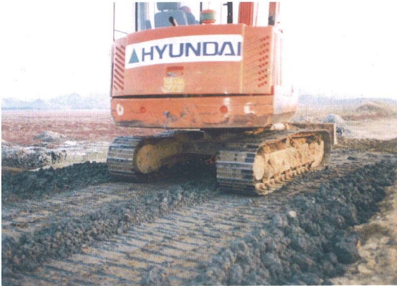
사진 5.7 함수비50% 흙시멘트(3%)처리 1시간후 백호다짐광경
