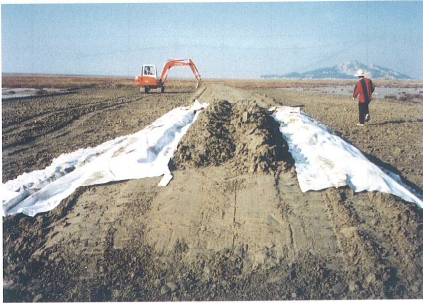
사진 부 1.3 간척지 표층토 성토후 사면보호용 매트포설
