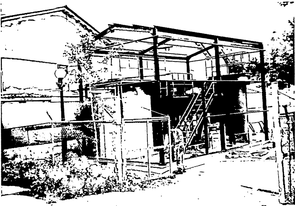
사진 3. 파일럿 플랜트 저류조, 포기조 및 구조물 설치 현황
