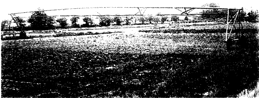
그림 3-21. 구조부가 조립되어 시험포장에 설치된 전경
