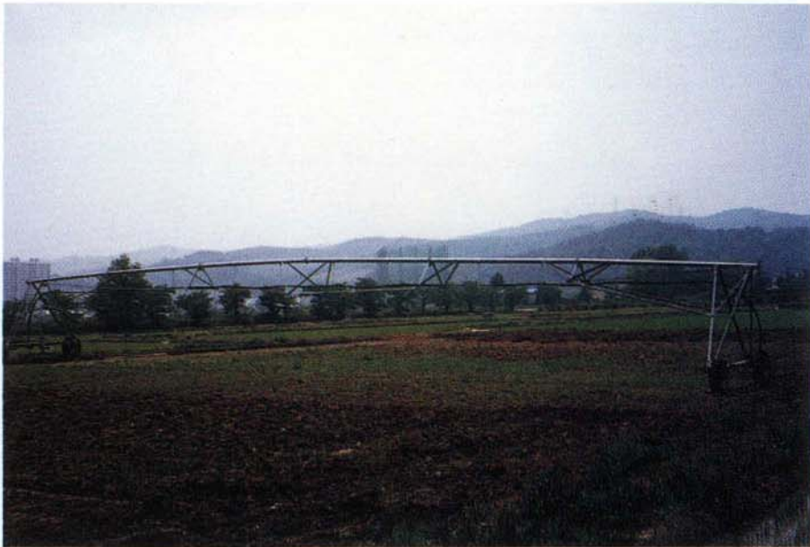
그림 3-21. 구조부가 조립되어 시험포장에 설치된 전경
