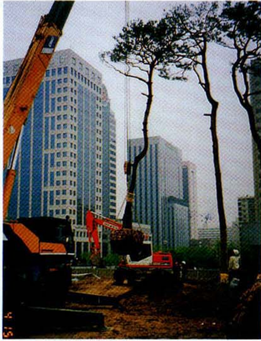
<사진 22> 크레인을 이용한 대목의 하차
