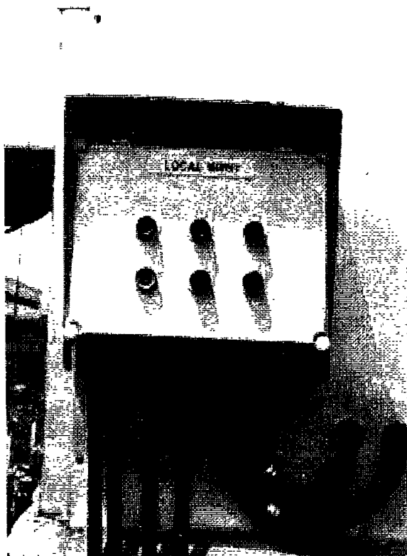
Photo. 3. Local Switch Box 외관
