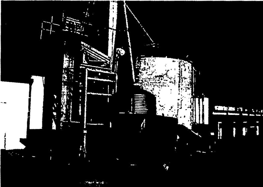
사진 6-2 개발된 곡물 냉각기를 사일로에 설치함.
