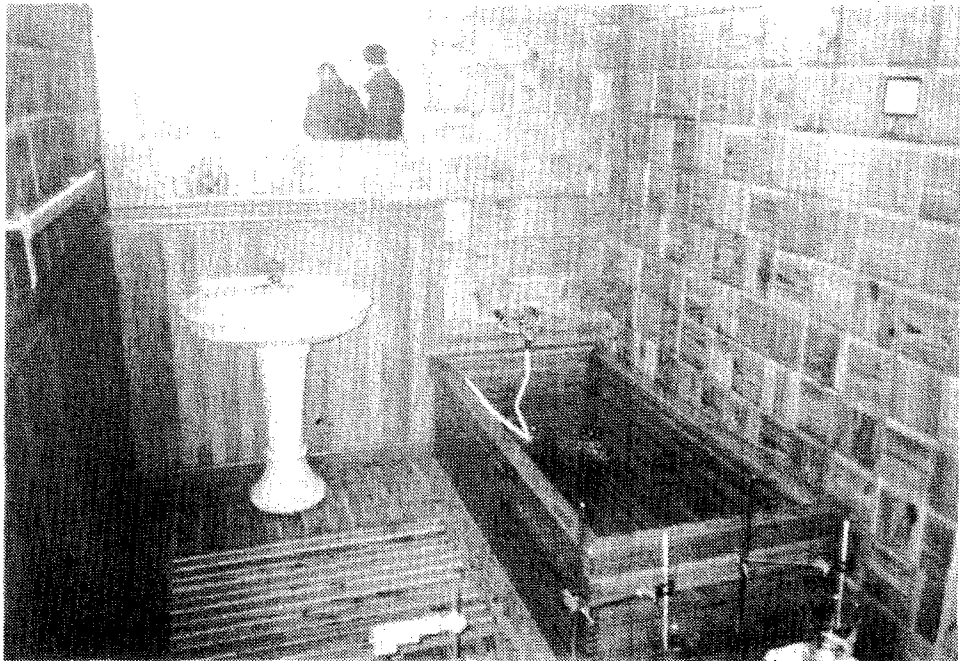
사진 4-4. 낙엽송(위)과 레드오크(아래)로 제작한 목제욕조 및 목제타일로 시공한 욕실
