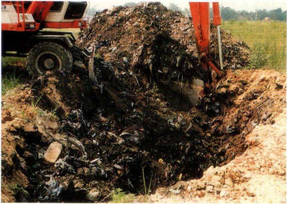
<사진 4-1> 매립쓰레기 굴착 장면
