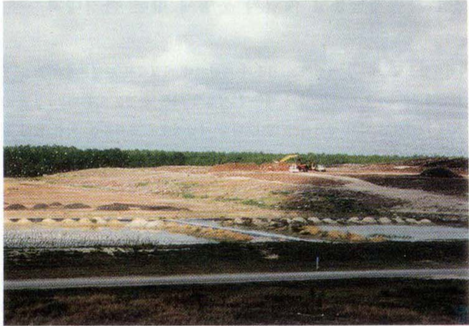
<사진 5-3> 매립지 선별토사를 활용한 매립지 복토 장면
