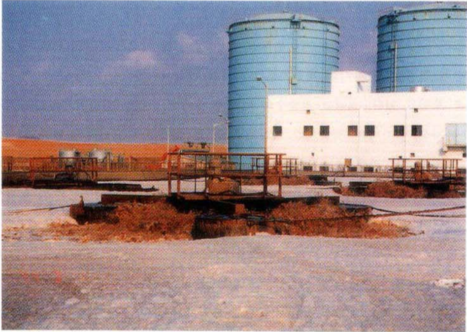
<사진 4-3> 김포 매립지 침출수 처리시설
