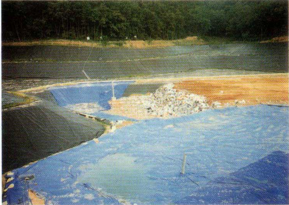
<사진 2-2> 우수배제를 위해 하절기 매립작업 공간을 최소화시킨 장면
