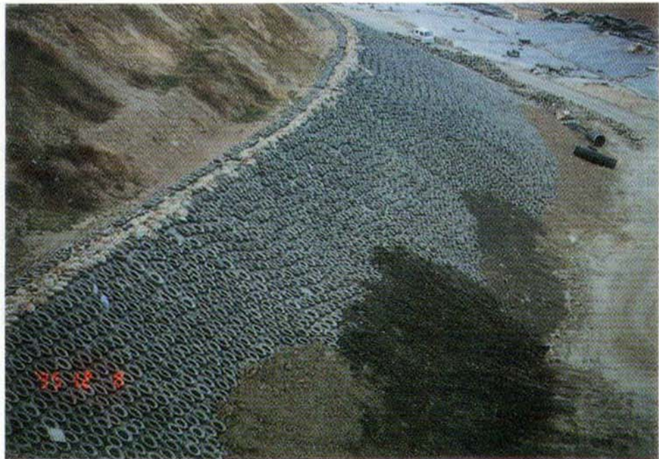
<사진 5-4> পেটাই어를 매립지 차수시트 보호재로 활용한 사례
