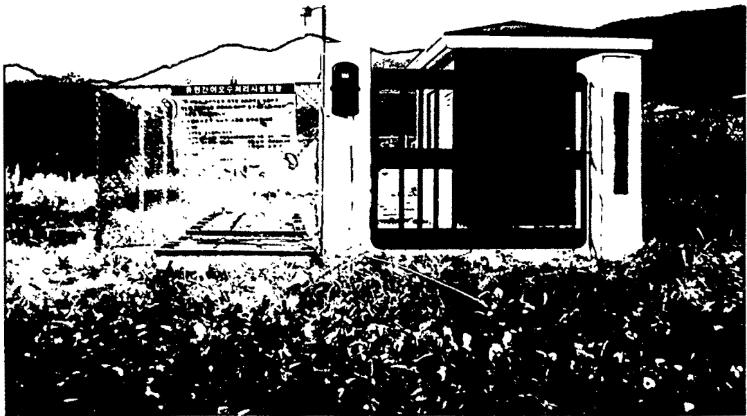
그림 3-2-3-2 접촉산화법에 의한 처리시설 전경(홍천군 동면 속초리 덕고개)
