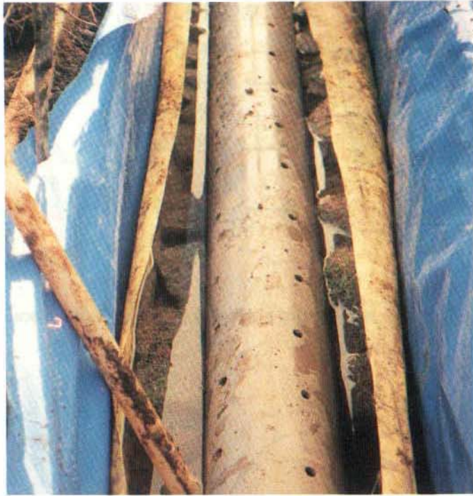
그림 3-4-2-15 토양필터의 유공 오수분배관 실상도(field scale)
