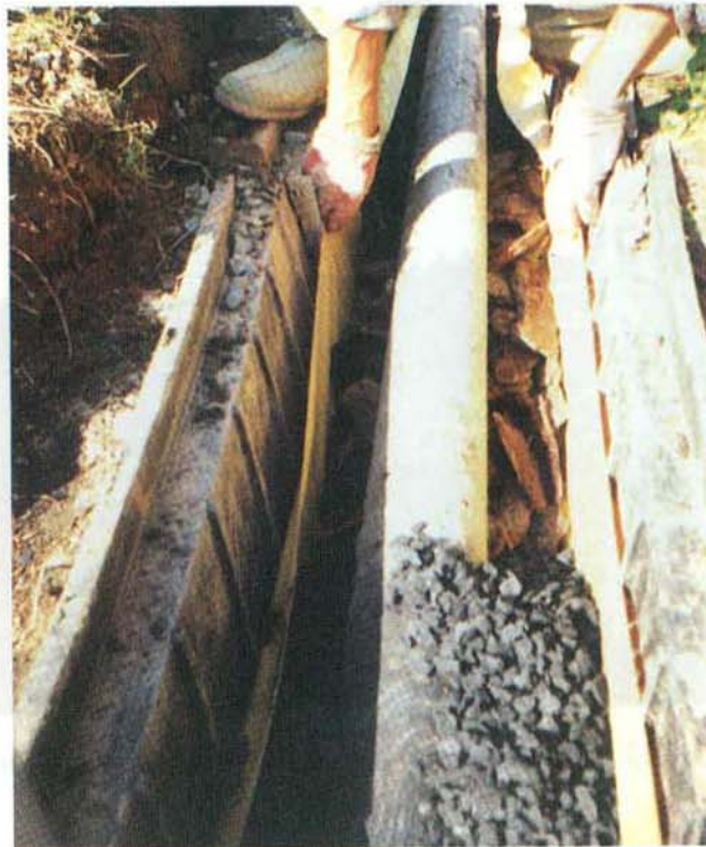
그림 3-4-2-14 시공중인 토양필터시스템(field scale)
