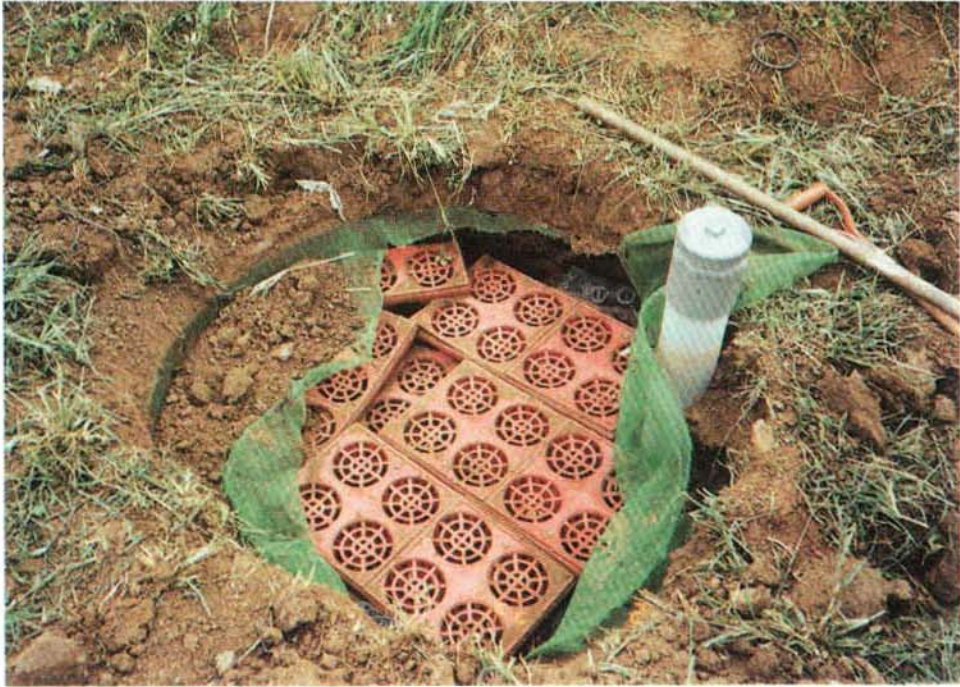
그림 3-4-2-12 상자형 LP혼합여재층진 실상도(field scale)
