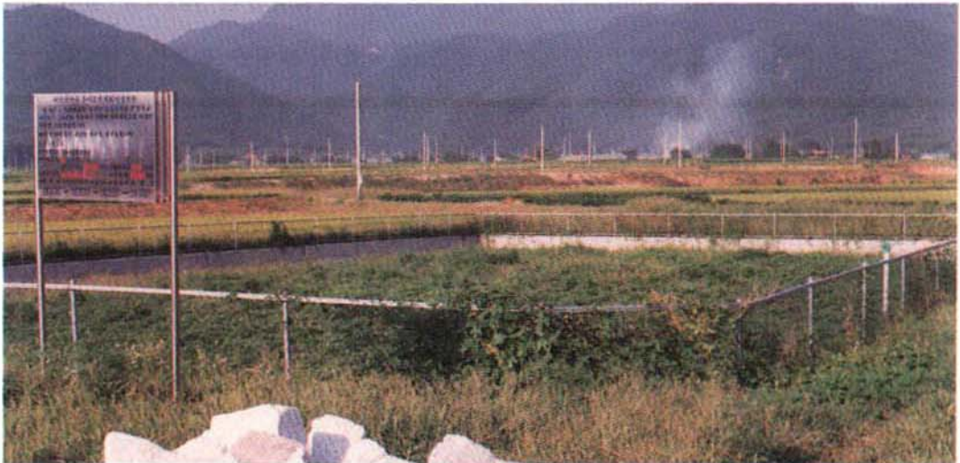
그림 3-2-3-6 모관침윤트렌치공법 처리시설 전경 (춘천시 신북읍 발산리 바미리)
