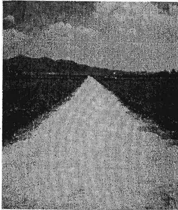
사진 5.1 현장시공된 RCCP의 전경
