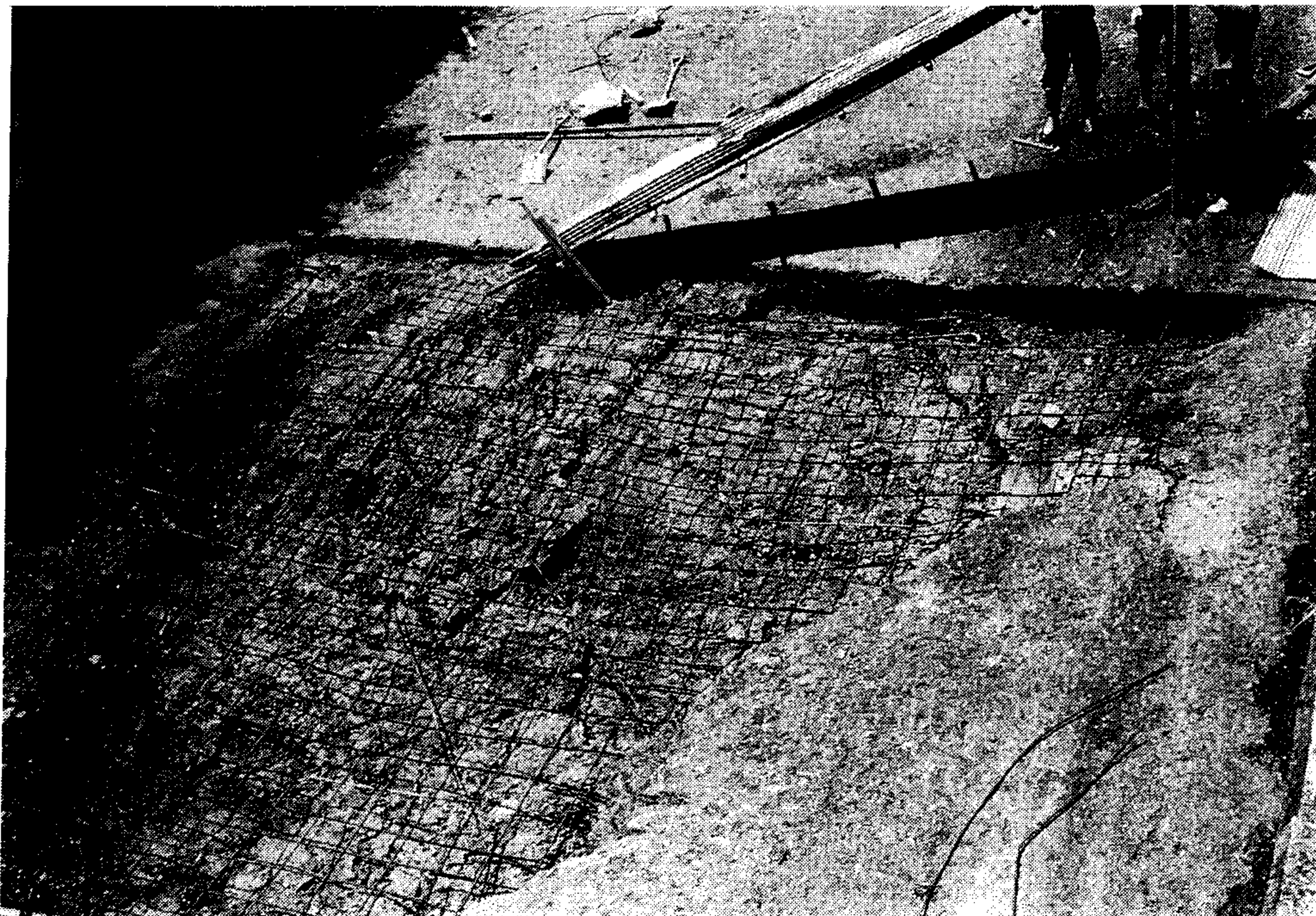
사진 4-4. 여수토 보수지의 철근 재조립
