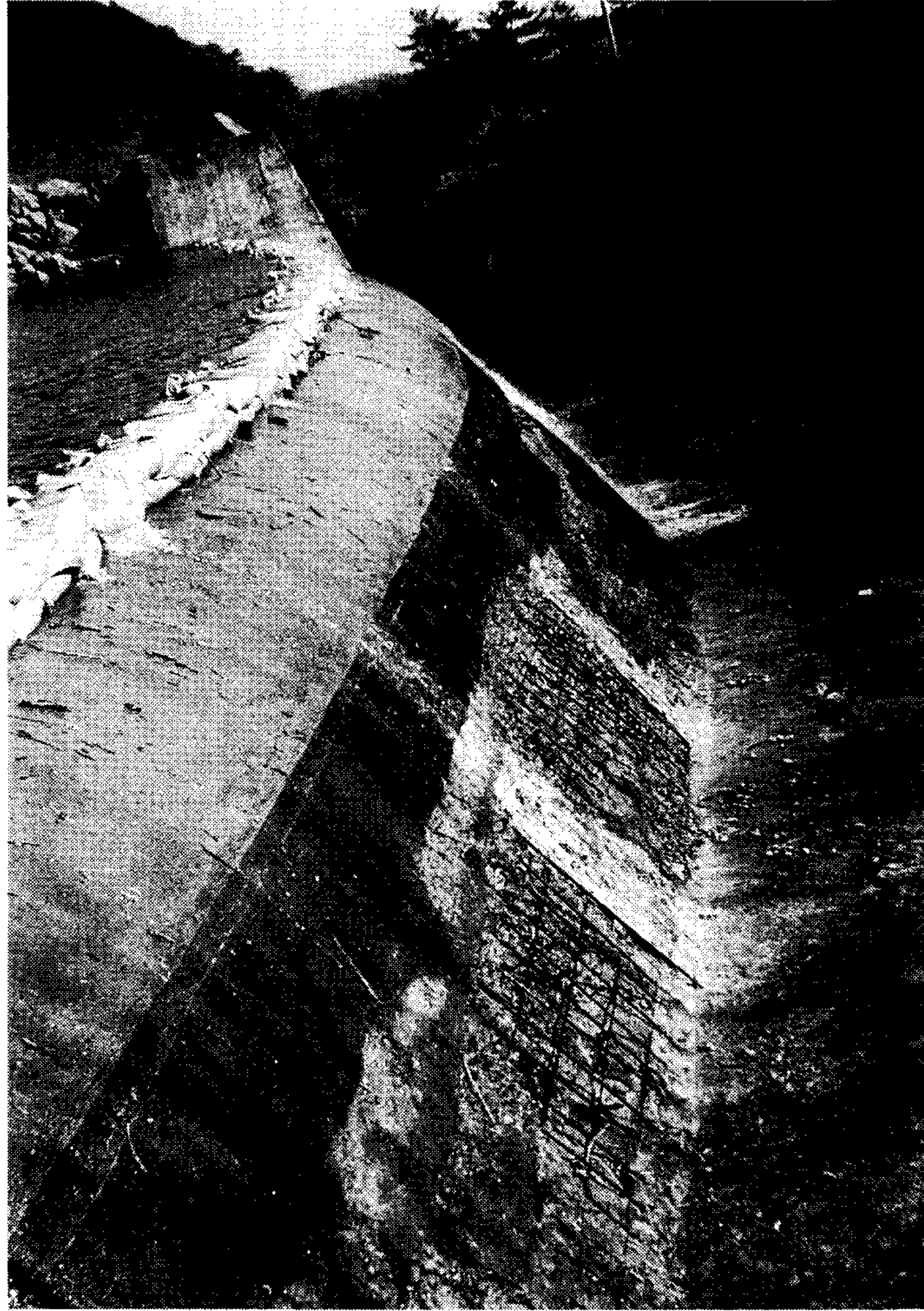
사진 2-5 저수지 E의 손상현황
