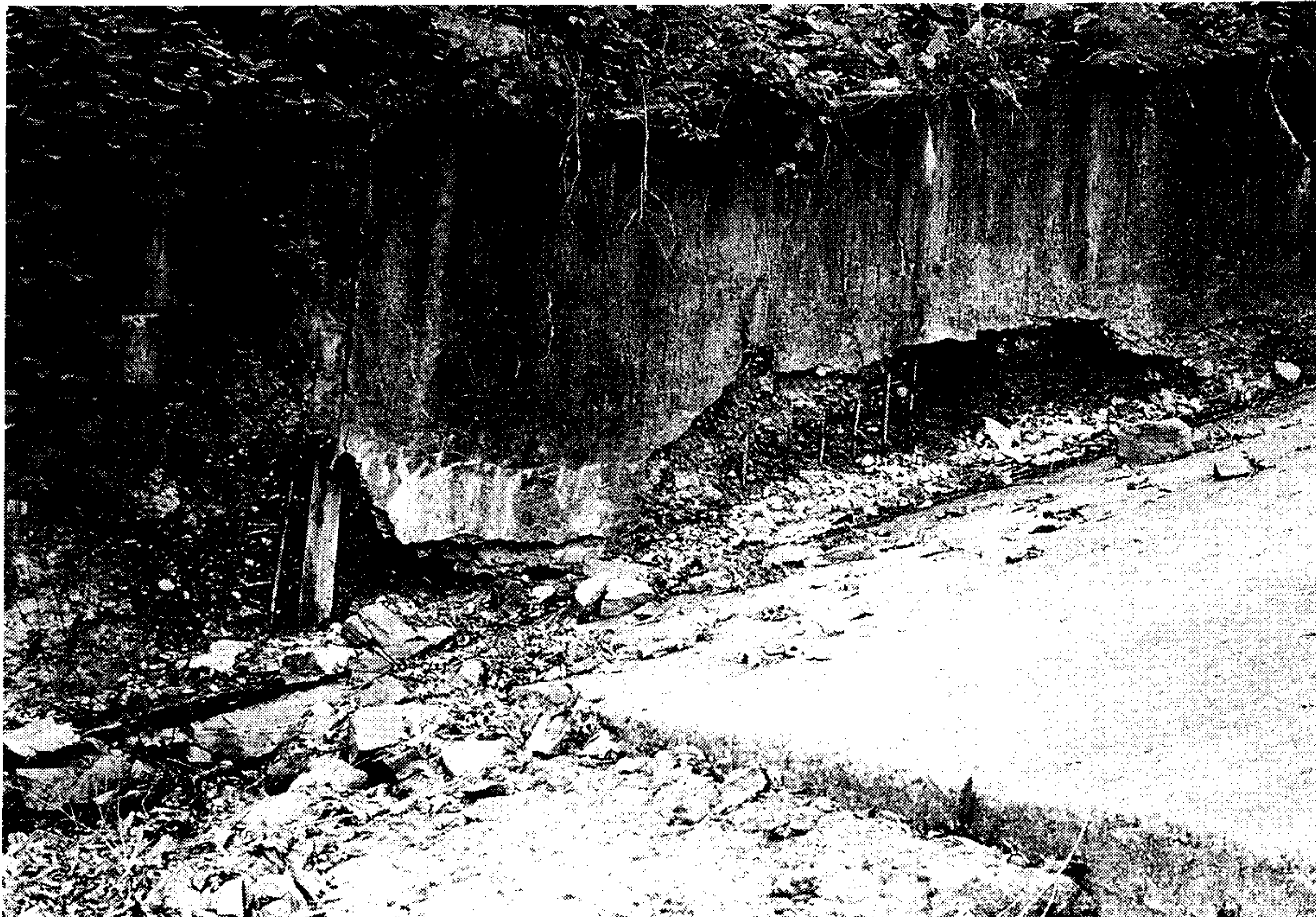
사진 4-2. 여수토 벽면 손상상태
