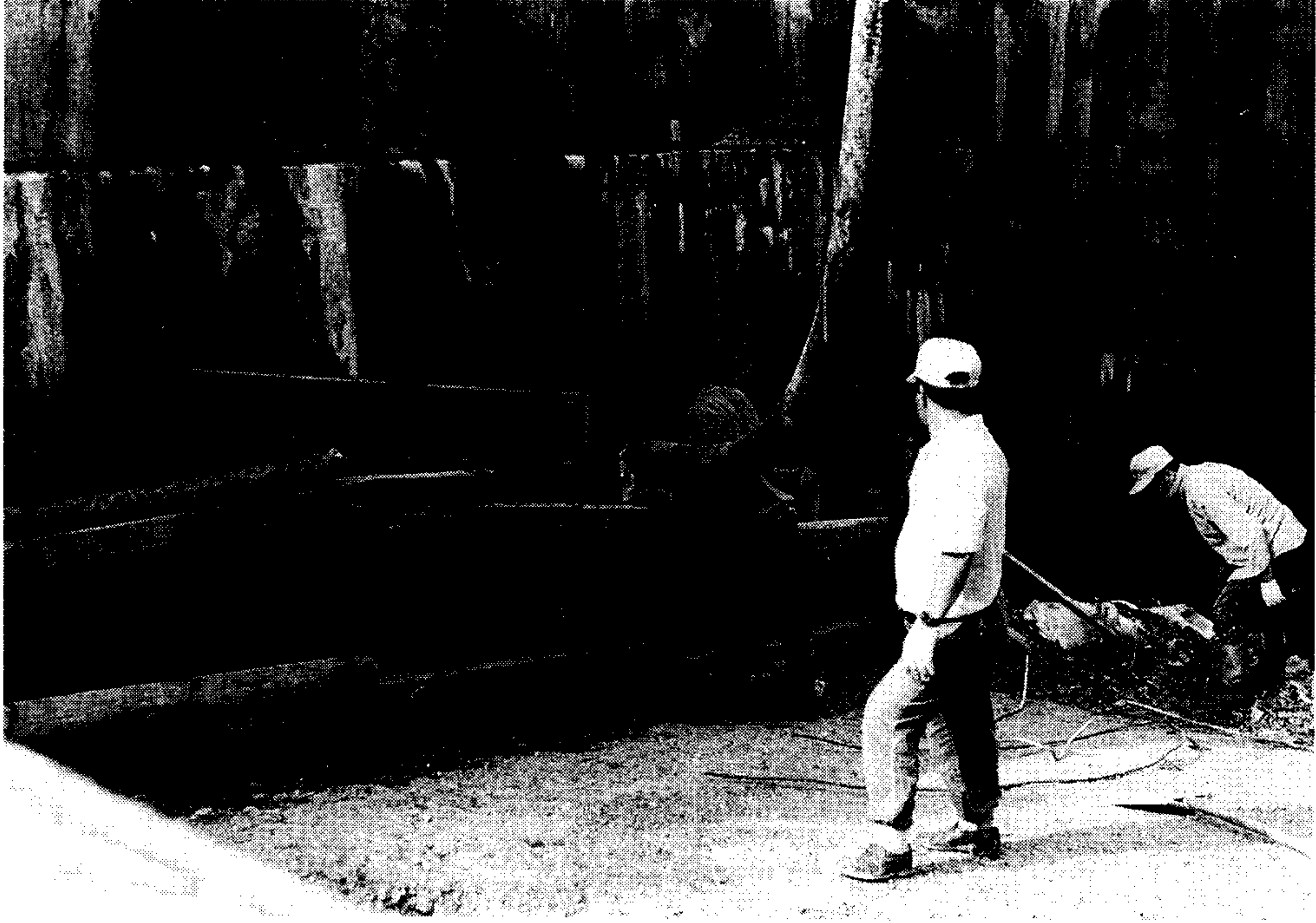
사진 4-8. 콘크리트 펌프를 이용한 여수토 벽면 타설
