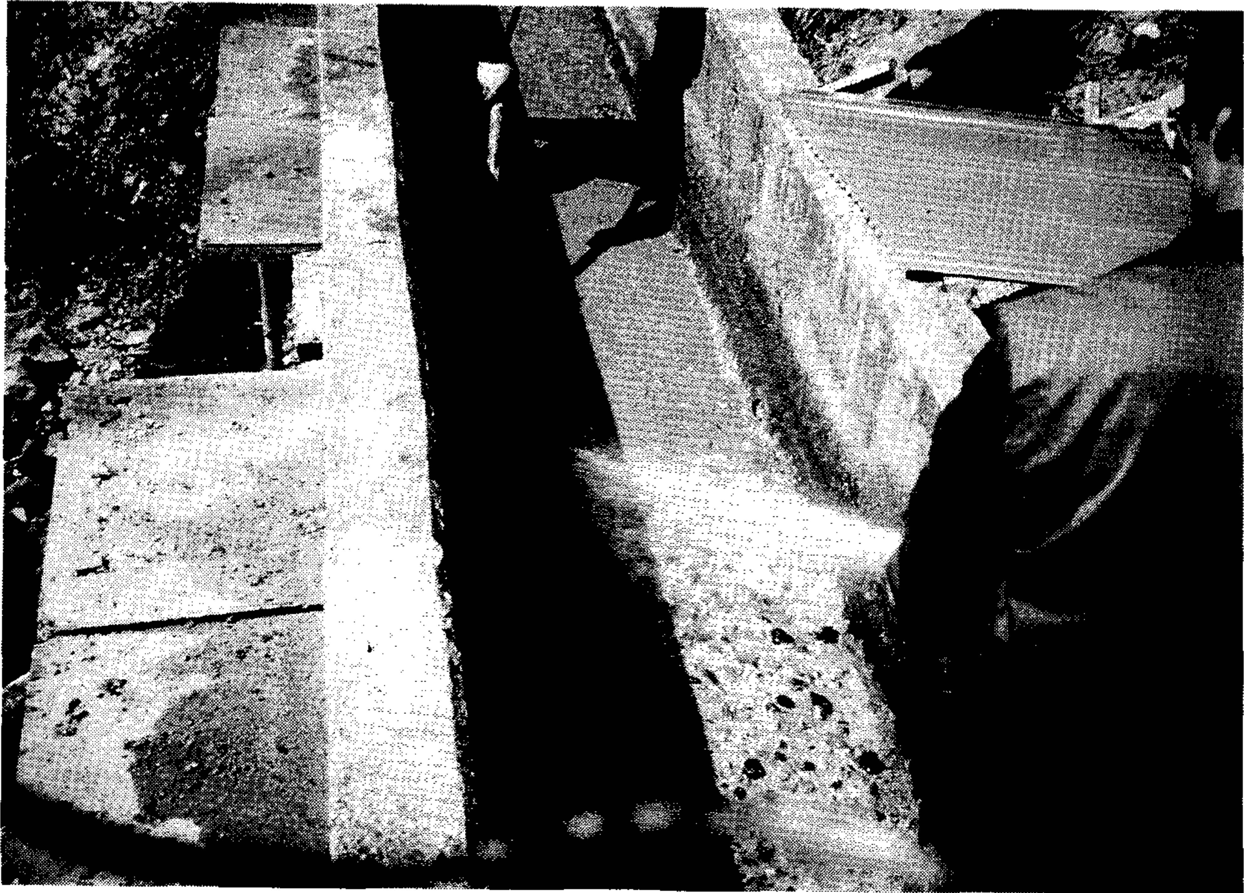
사진 4-12. water jet을 이용한 바닥면 표면 청소
