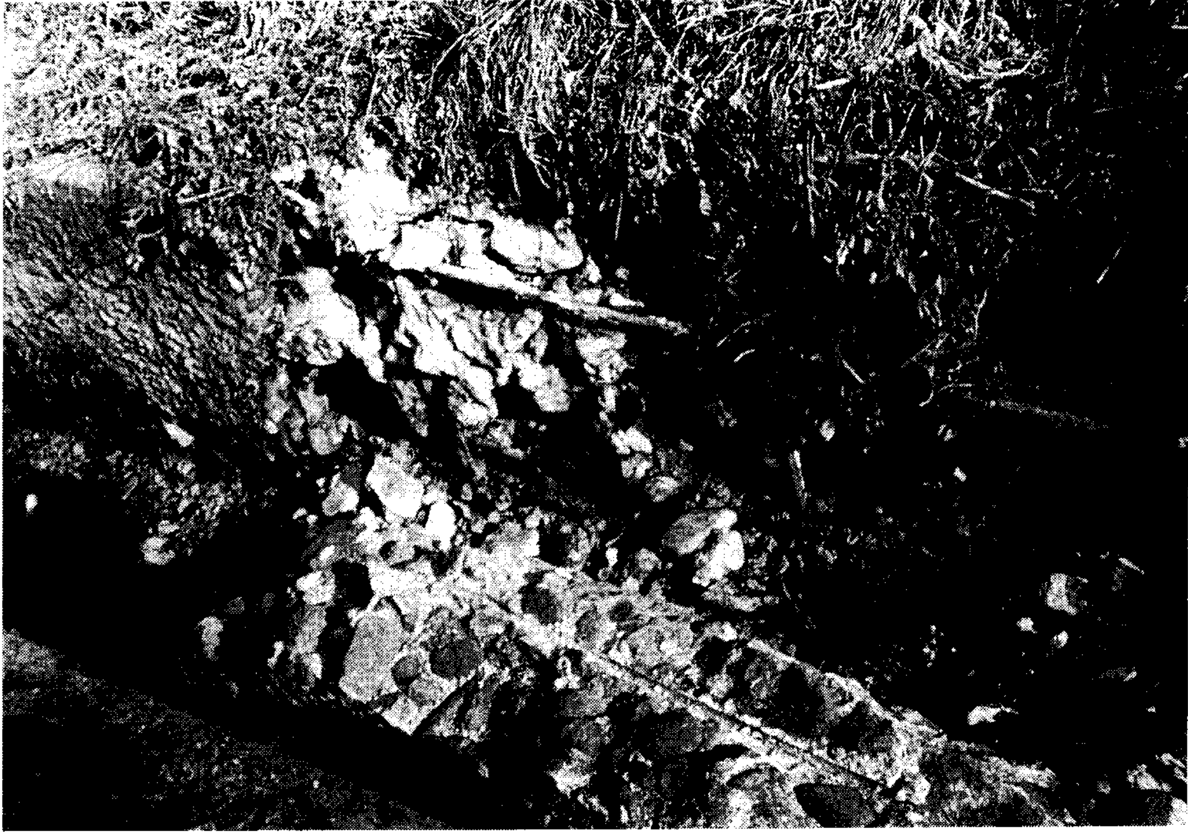
사진 2-7 개거 A의 손상현황
