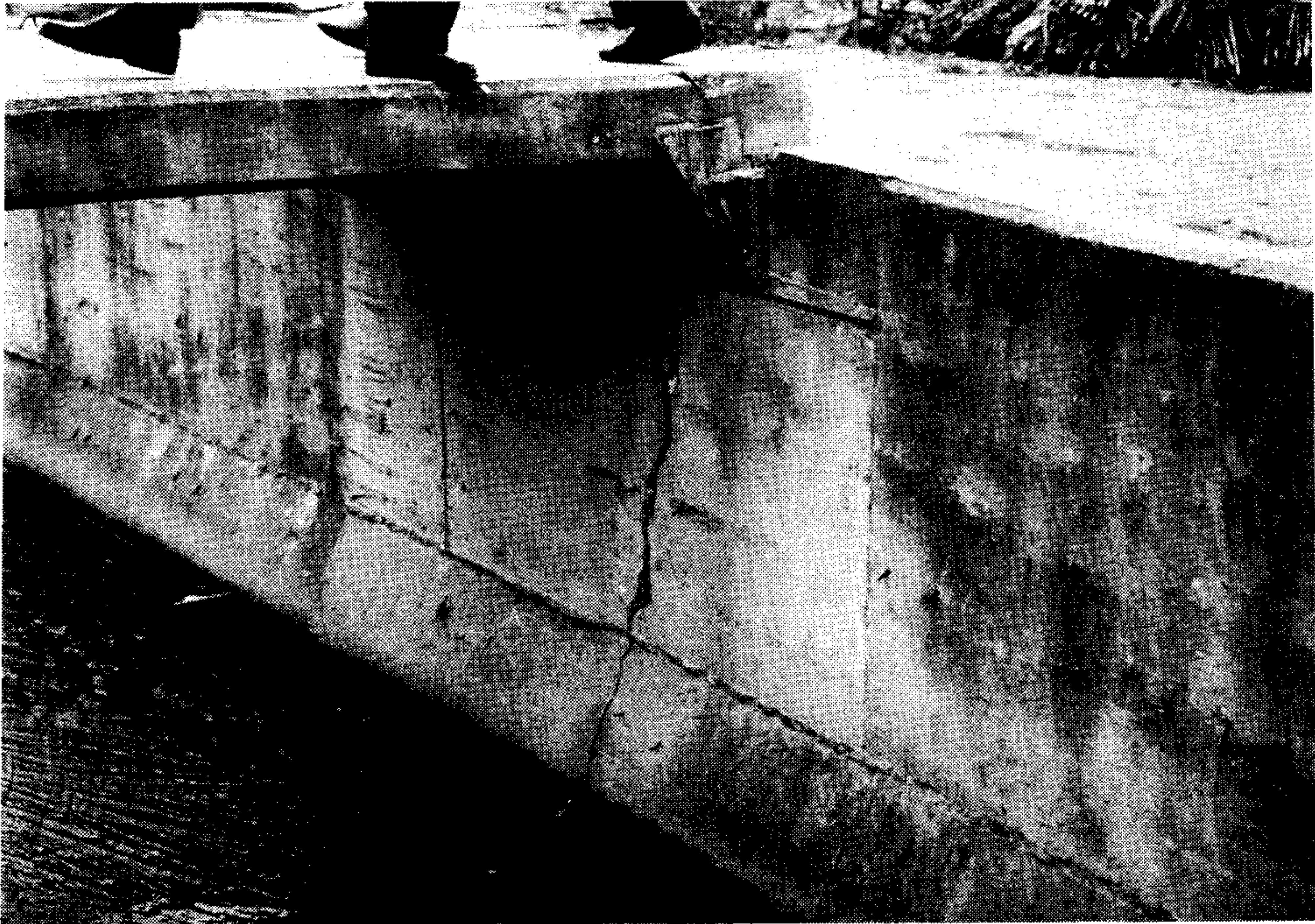
사진 4-21. 개거 균열 손상상태
