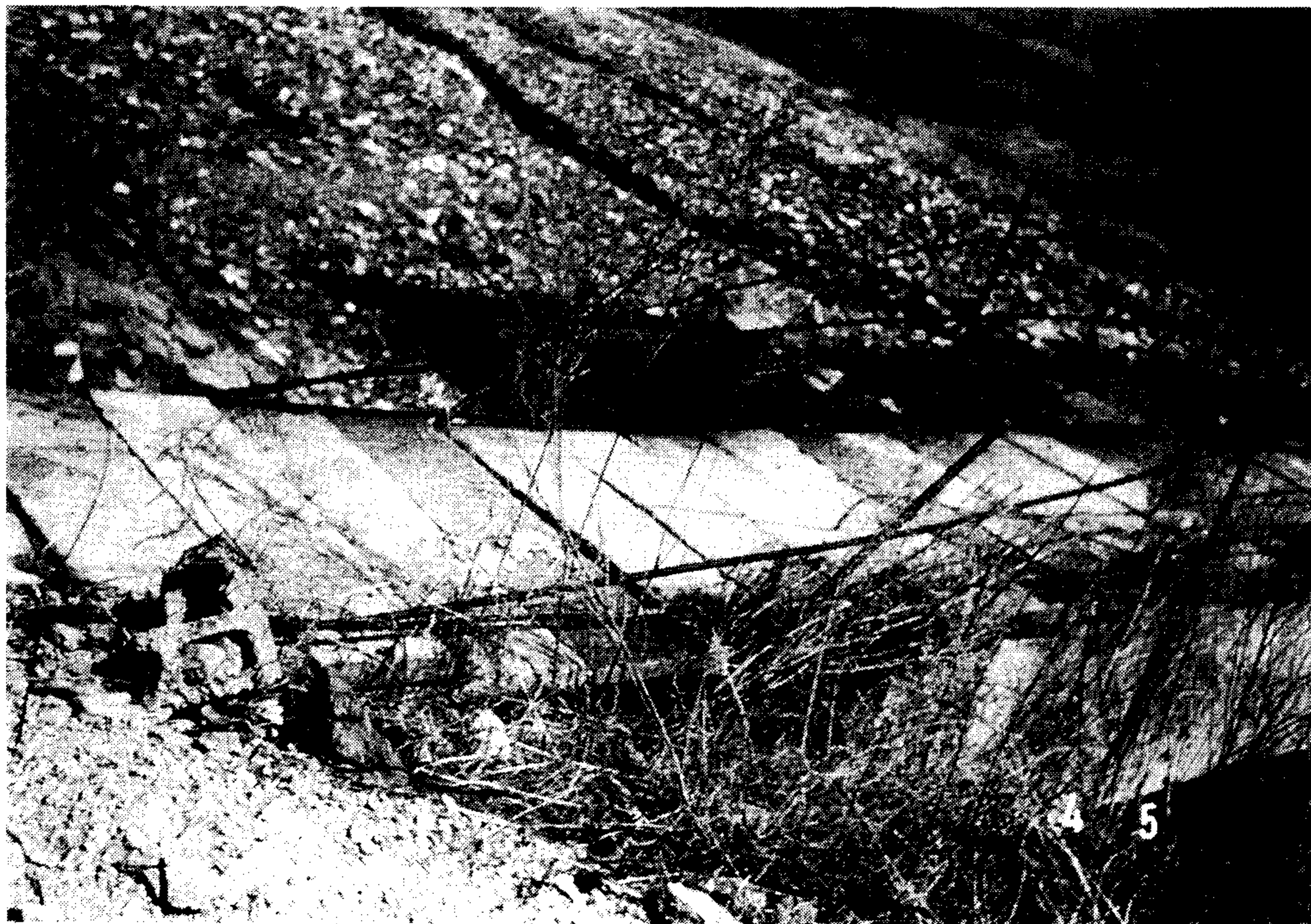
사진 2-12 수로교 B의 손상현황
