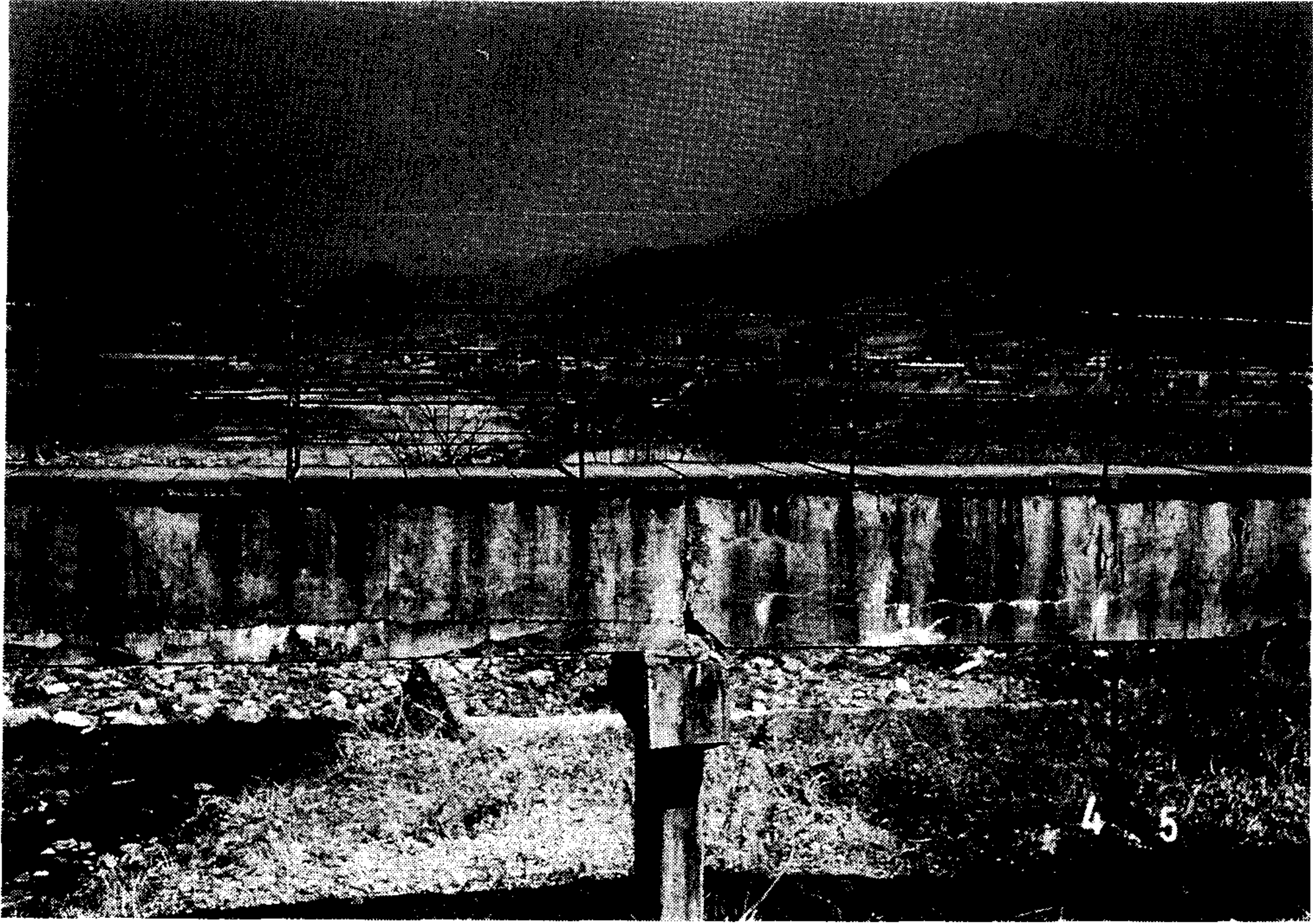
사진 2-13 수로교 C의 손상현황
