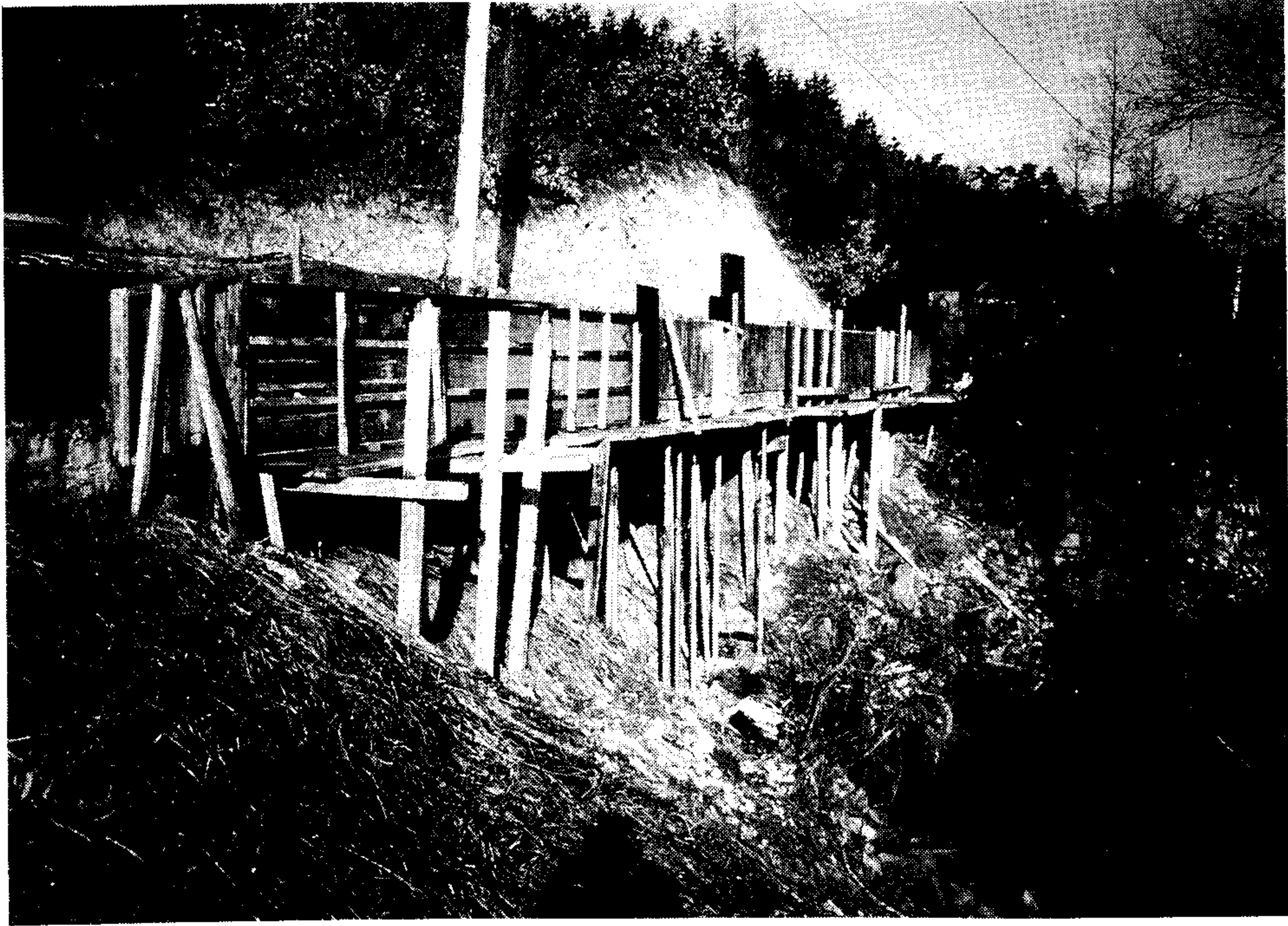
사진 4-13. 거푸집 설치
