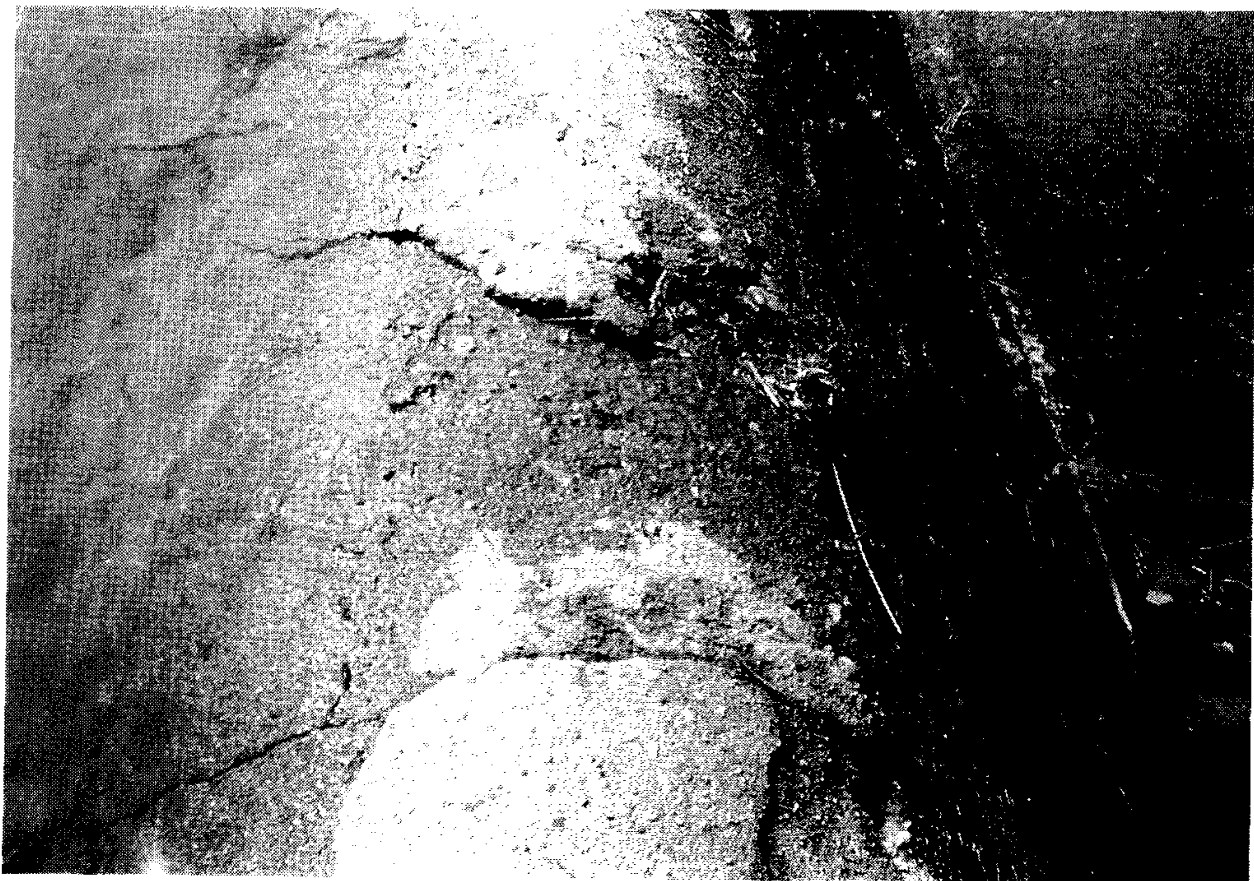
사진 2-3 저수지 C의 손상현황
