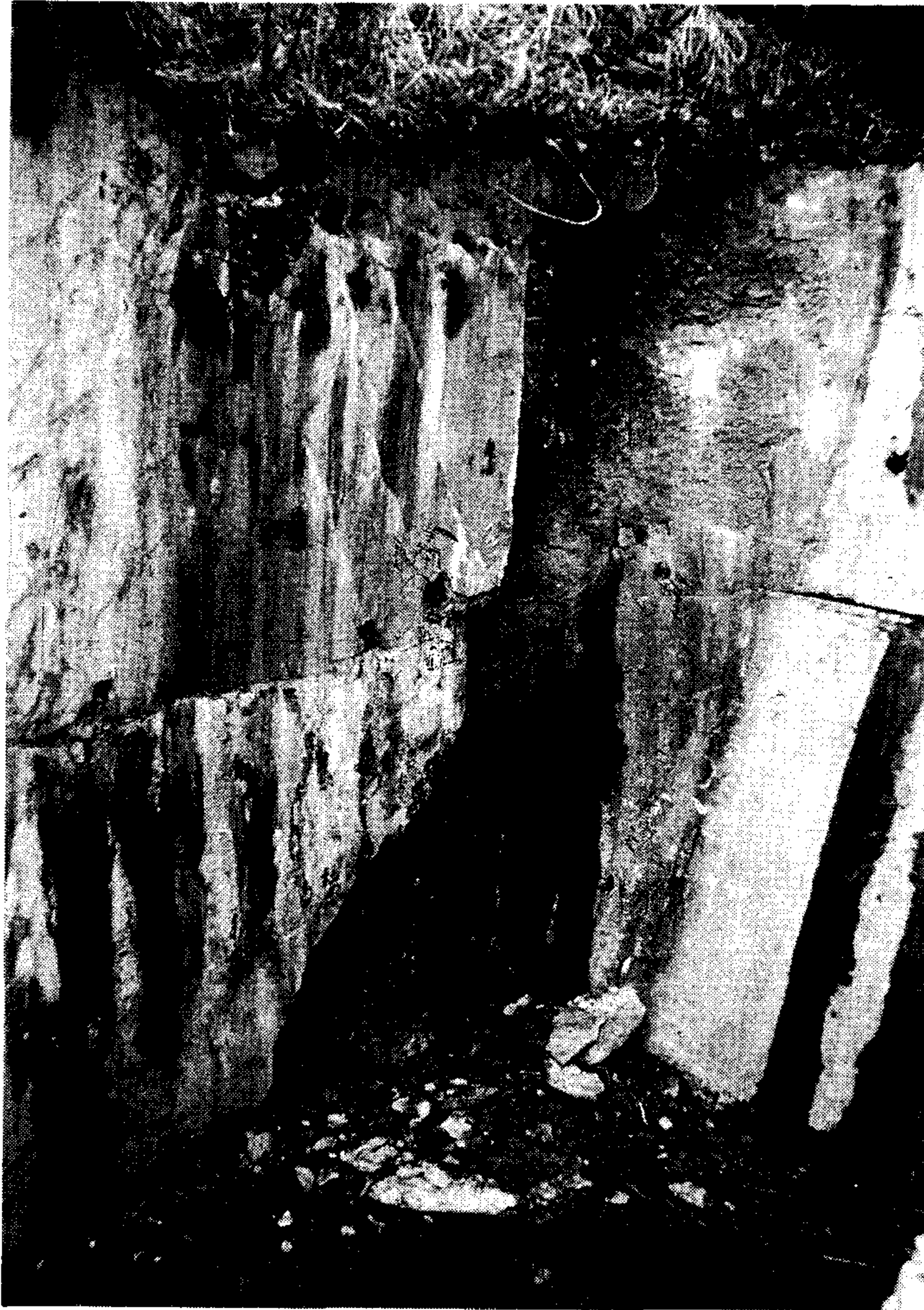
사진 2-6 저수지 F의 손상현황
