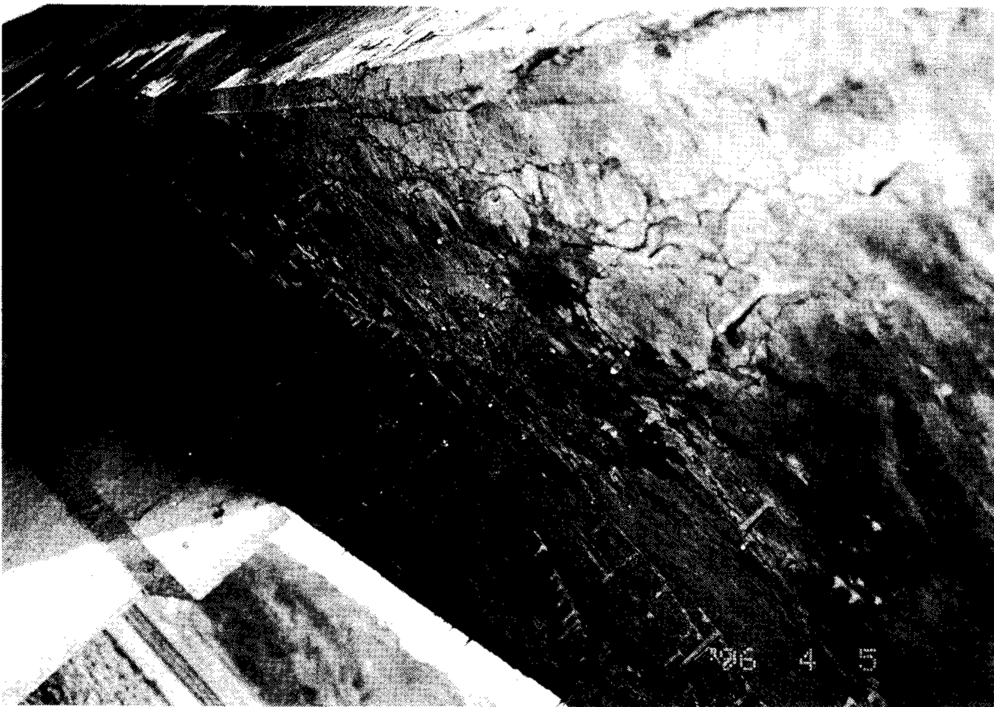
사진 2-8 개거 B의 손상현황
