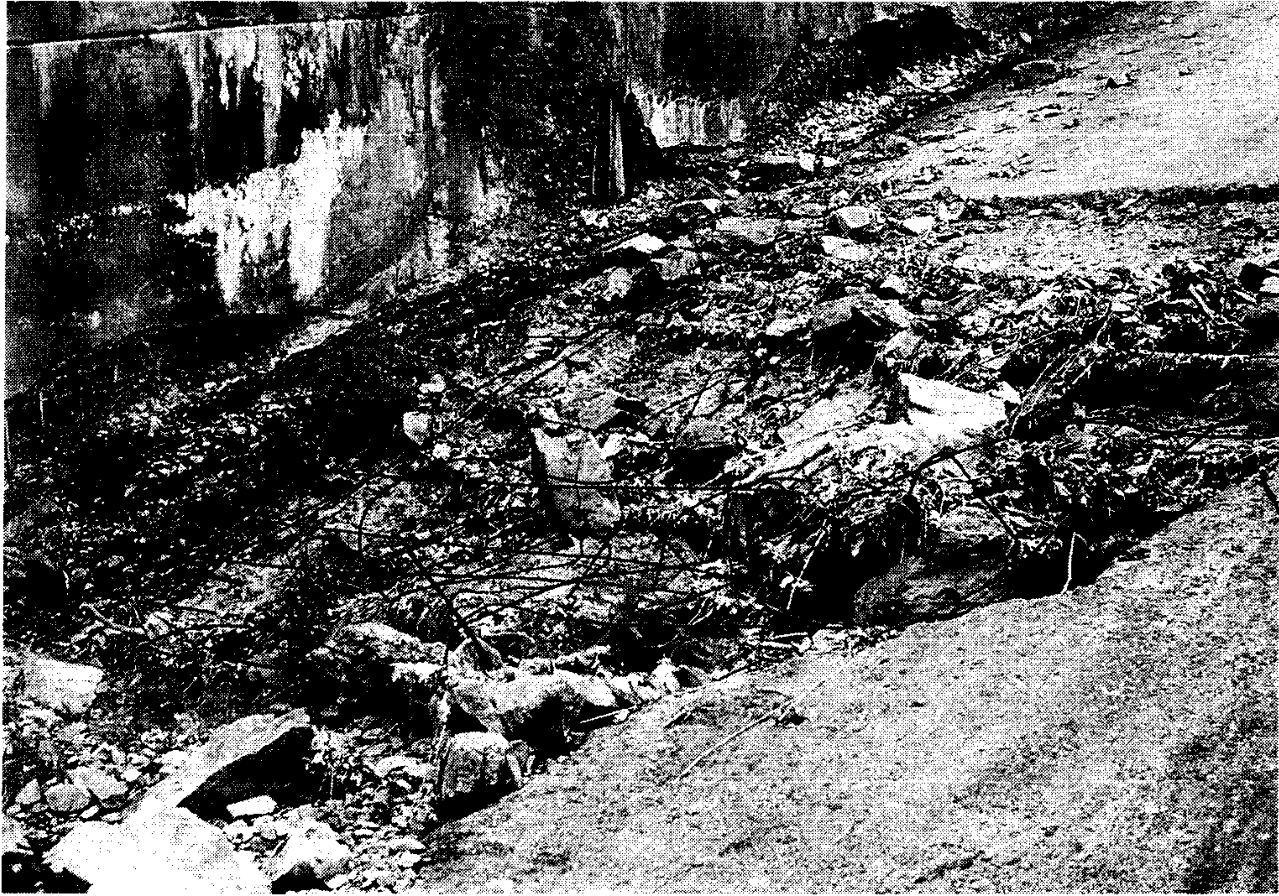
사진 4-1. 여수토 바닥면 손상상태
