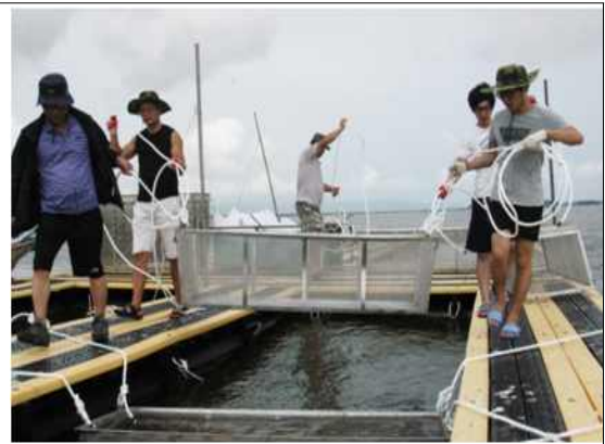
그림 3-4-31. 스테인레스 재질(sus316L) 양성기 설치
