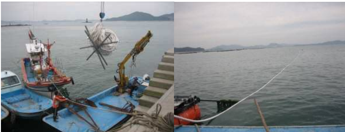
그림 3-4-8. 해면중간육 가두리시설 철재앵커를 이용한 계류시설
