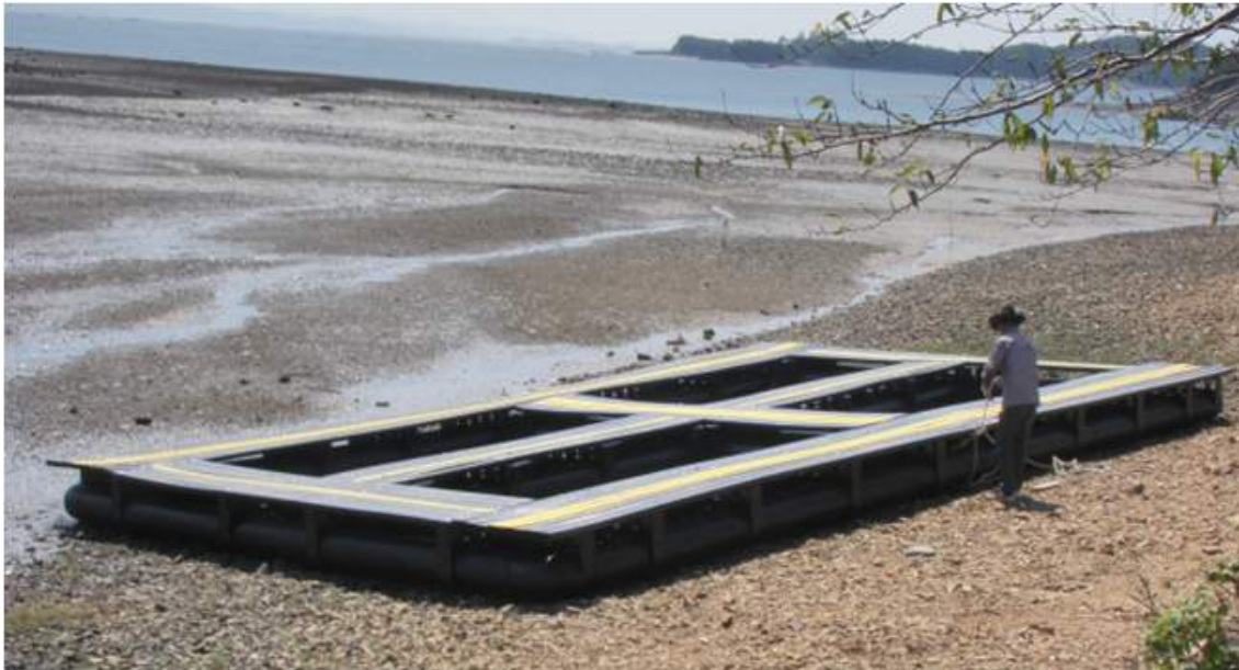
그림 3-4-7. 해면중간육성 가두리 제작 완료장면
