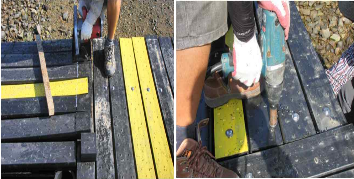
그림 3-4-6. 발판 이음부 절단 및 마무리작업
