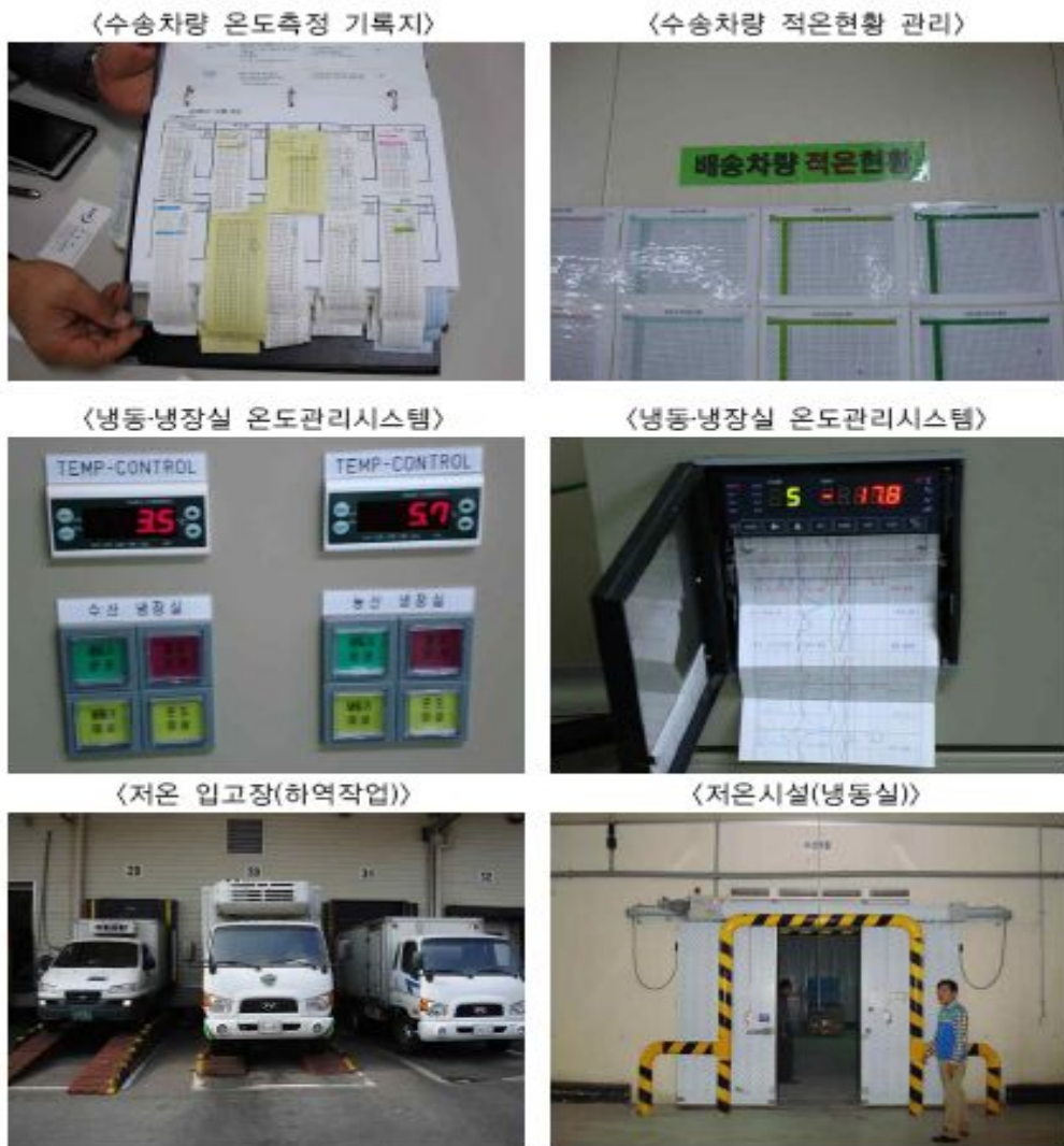
<그림 3-11> 대형마트 물류센터의 수산물 저온유통시설 전경
