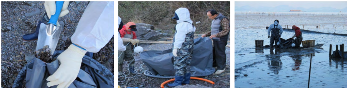
그림 3-4-40. 방수천 설치 도안과 설치 전경
