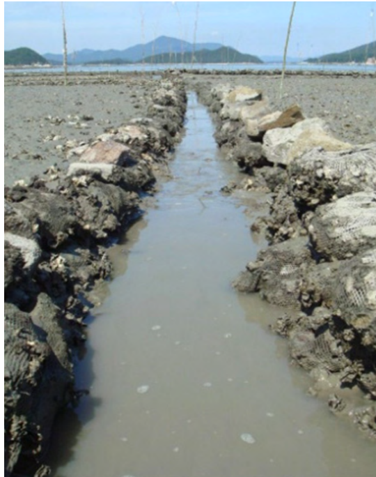
그림 3-3-3. 경계석형의 갯벌경계둑의 모습
