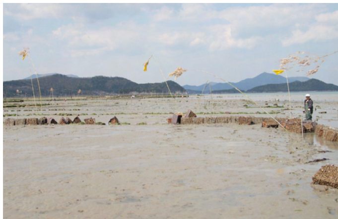
(c) 경계석 설치 전경
