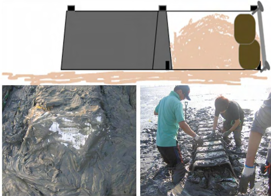
그림 3-4-14. 갯벌두렁 구조물 설치 시 빈 공간 처리 모습
