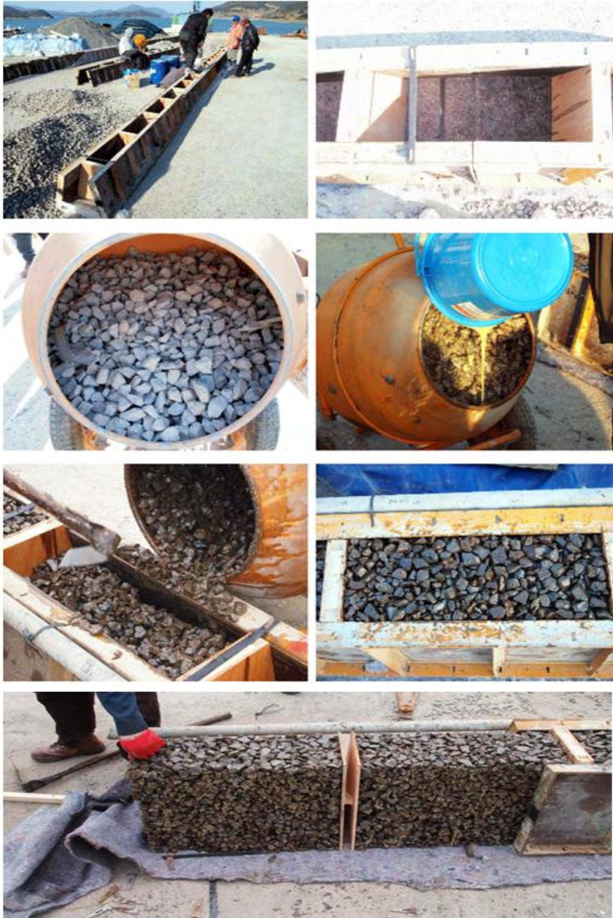
그림 3-4-3. 양식장의 구조물(경계석) 만드는 과정
