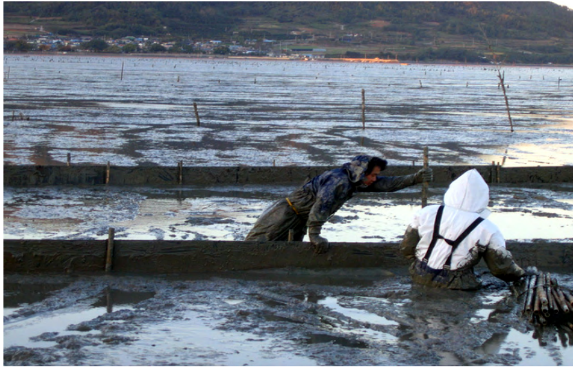
그림 3-4-22. 대나무(판과 판사이)와 앵글(판의 모서리)를 이용한 PE판넬 고정
