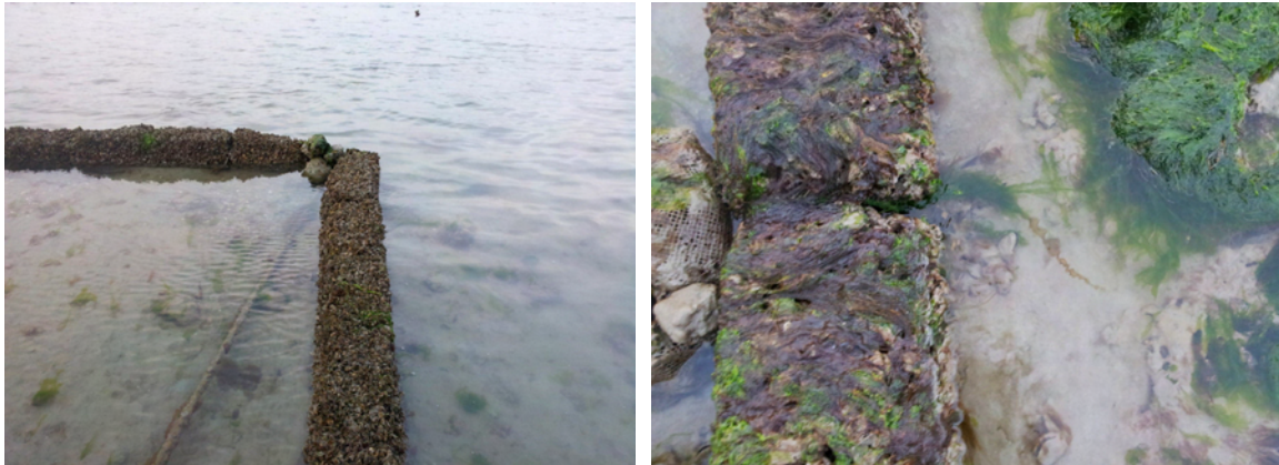
그림 3-4-8. 갯벌독사이 해수유출에 의한 세굴발생
