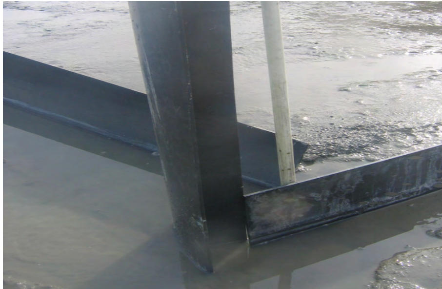
(a) T-이음기둥 설치
