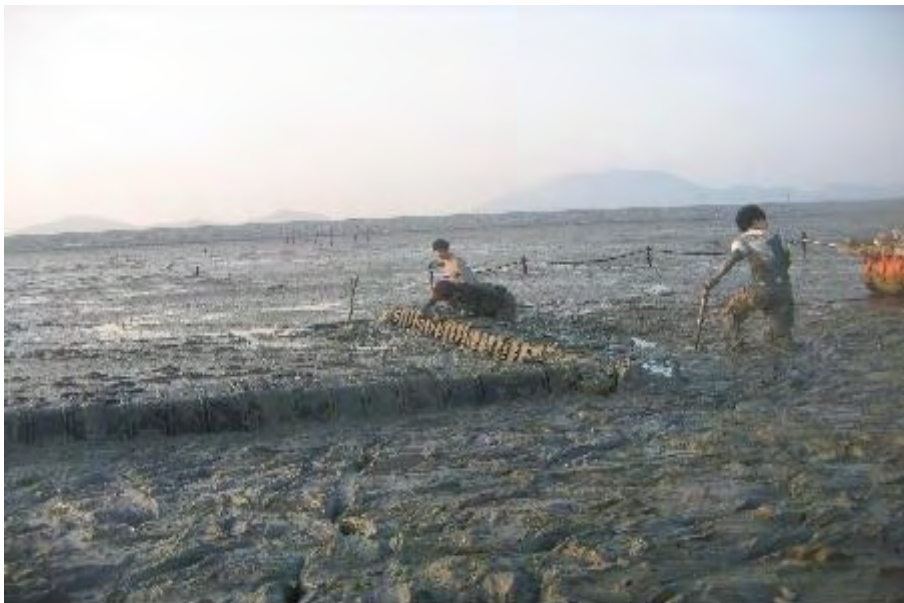
그림 3-4-15. 갯벌두렁 현장 구조물 설치 작업
