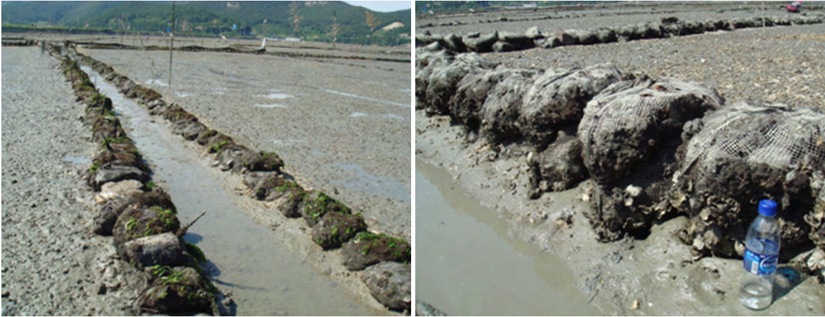
그림 3-3-2. 자루적재형 갯벌경계둑의 모습
