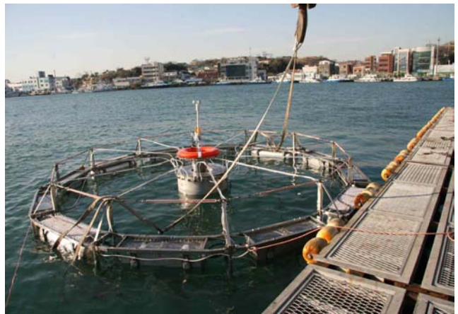
<그림 3-182> 2차 시작품의 현장 실험을 해상 운반 및 설치.
