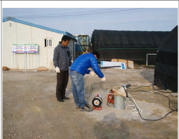
영백지구 BH-3호공 양수시험 전경
