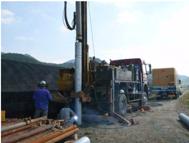
영백지구 BH-3호공 시추조사 전경
