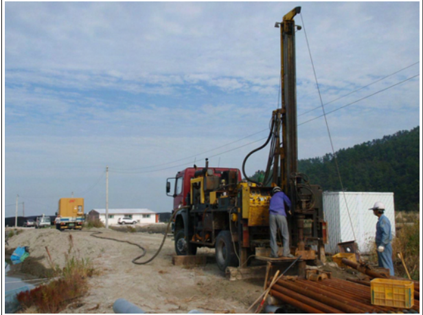
영백지구 BH-2호공 시추조사 전경
