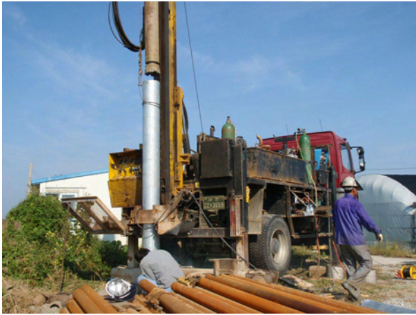
영백지구 BH-1호공 시추조사 전경
