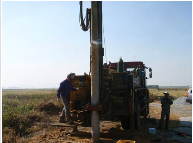
영백지구 BH-4호공 시추조사 전경
