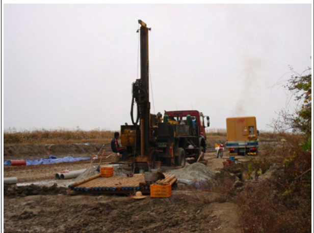
영백지구 BH-6호공 시추조사 전경
