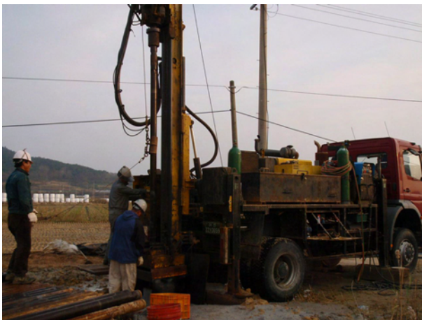
영백지구 BH-5호공 시추조사 전경
