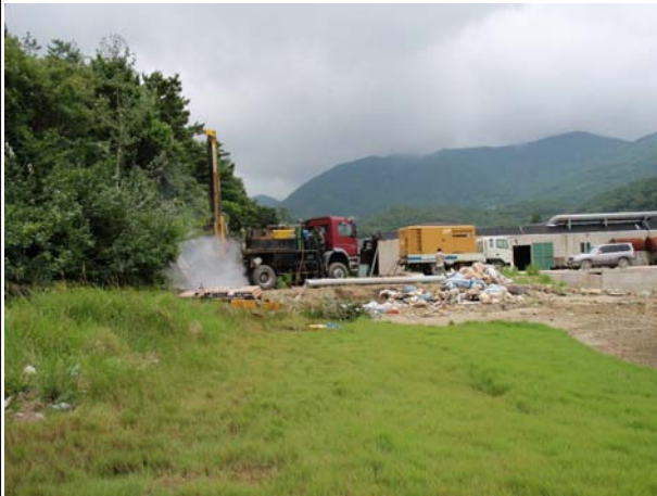
완군2지구 BH-3호공 시추조사 전경
