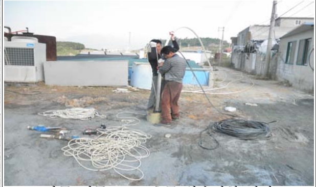
완군2지구 BH-4호공 양수시험 전경
