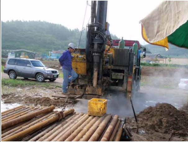
완군2지구 BH-1호공 시추조사 전경
