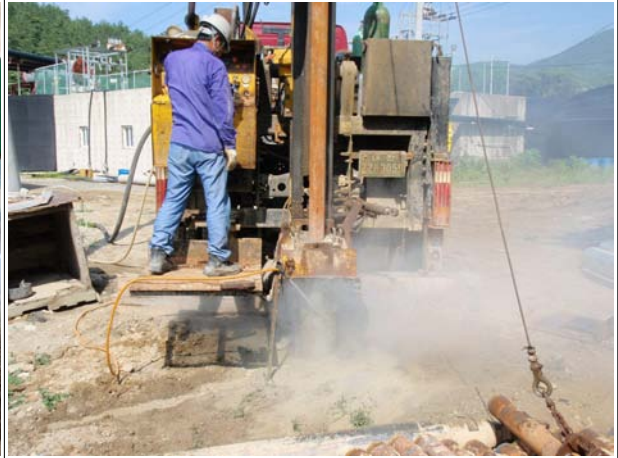
완군2지구 BH-2호공 시추조사 전경
