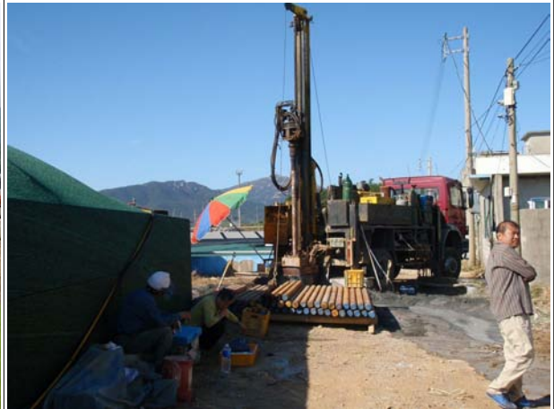
완군2지구 BH-4호공 시추조사 전경
