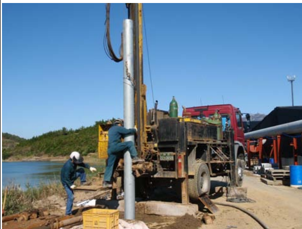
완군2지구 BH-3호공 시추조사 전경
