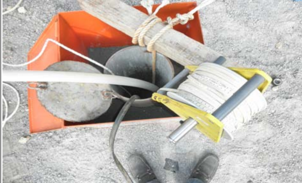
완군2지구 BH-3호공 양수시험 전경
