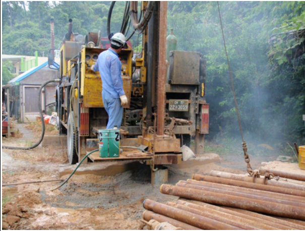
무해지구 BH-1호공 시추조사 전경
