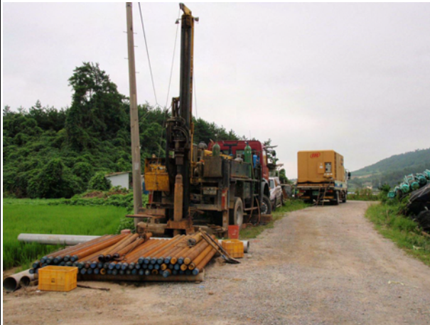
무해지구 BH-3호공 시추조사 전경
