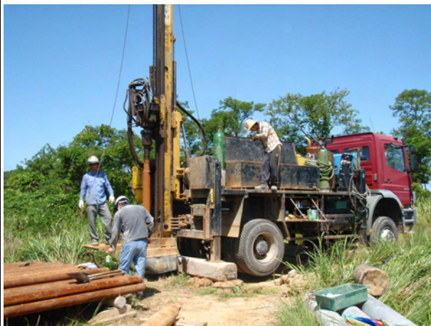
무해지구 BH-5호공 시추조사 전경
