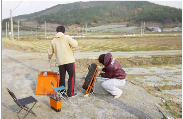
무해지구 BH-3호공 물리검층 전경
