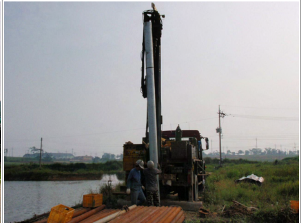
무해지구 BH-4호공 시추조사 전경
