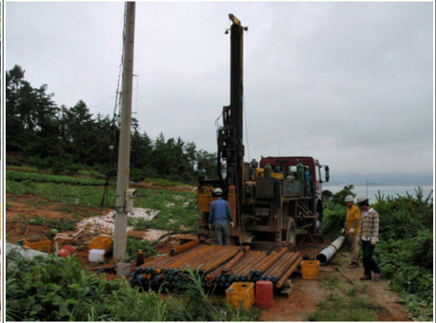
무해지구 BH-2호공 시추조사 전경
