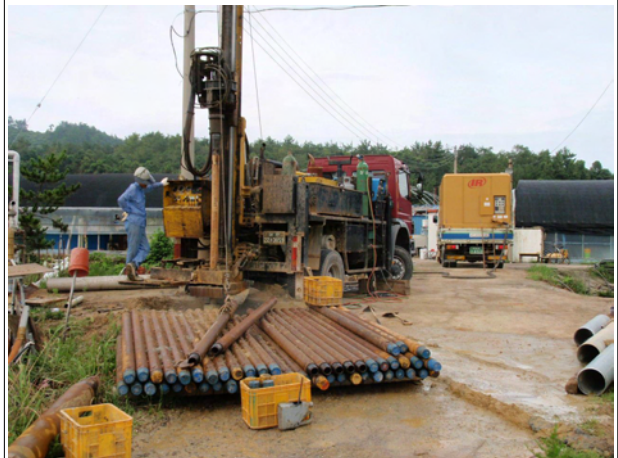
무해지구 BH-6호공 시추조사 전경
