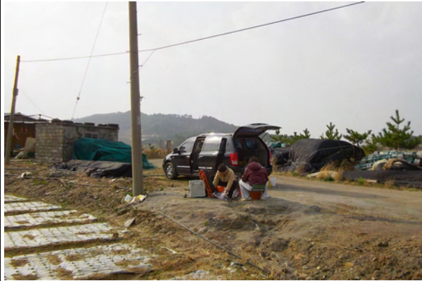
무해지구 BH-3호공 물리검층 전경
