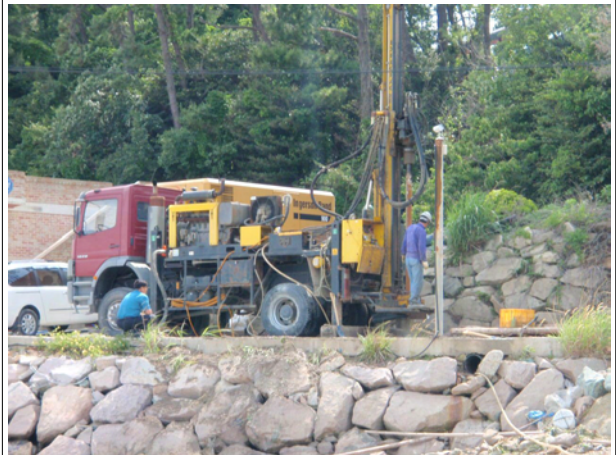
강마지구 BH-4호공 시추조사 전경
