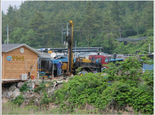
강마지구 BH-2호공 시추조사 전경
