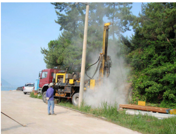
강마지구 BH-3호공 시추조사 전경
