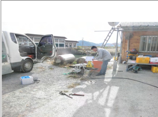
강마지구 BH-2호공 양수시험 전경
