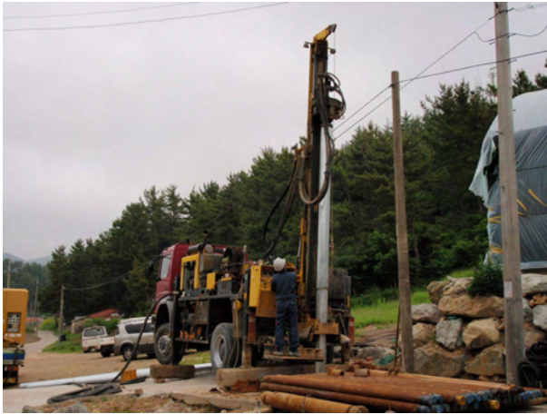
강마지구 BH-1호공 시추조사 전경
