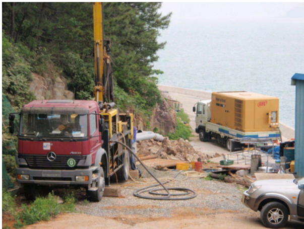
강마지구 BH-3호공 시추조사 전경
