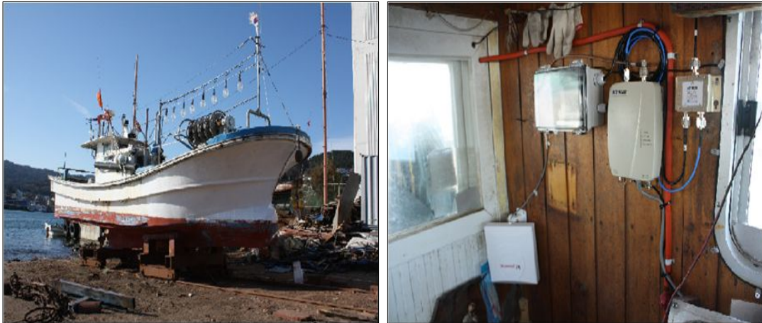
<그림 III-5> 동해지역 만선호에 위치발신장치와 통신장비시스템 설치 모습
