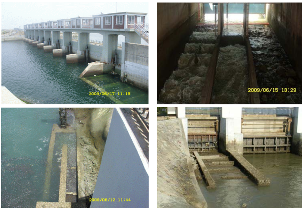
〈그림 29〉 배수갑문에 설치된 계단식 어도(부사방조제, 금강하구둑, 이원호, 고천암호)
