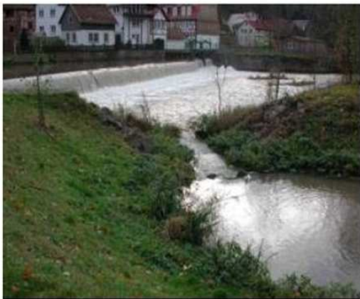
Location: Henfstadt, Thuringia, Germany River: Werra Type: pond-type bypass channel Headloss: ~2m Width: ~0.6-4m Length: ~90m Flow: ~0.05-0.1m 3 /s Contact: Arbeitsgemeinschaft zur Reinhaltung der Weser / Programm "Wiederansiedlung von Wanderfischen" Picture Source: Marq Redeker
