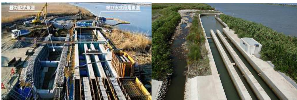
〈그림 4-4〉 利根川の 완구배식 자연형 어도(좌 : 자연형, 우 : 계단식 어도)
