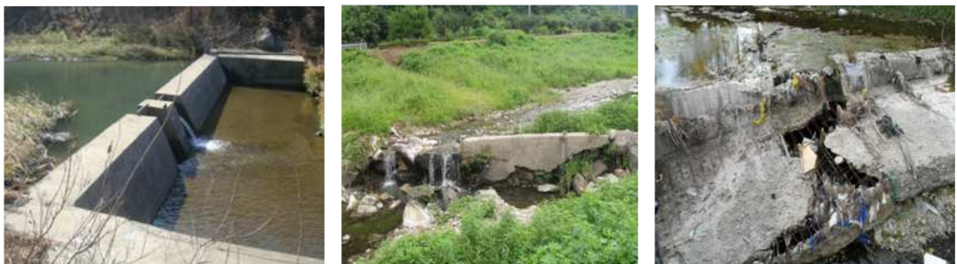
〈그림 7-3〉 어도 설치를 위한 보 상태 조사(좌 : 양호, 중 : 보통, 우 : 불량)
