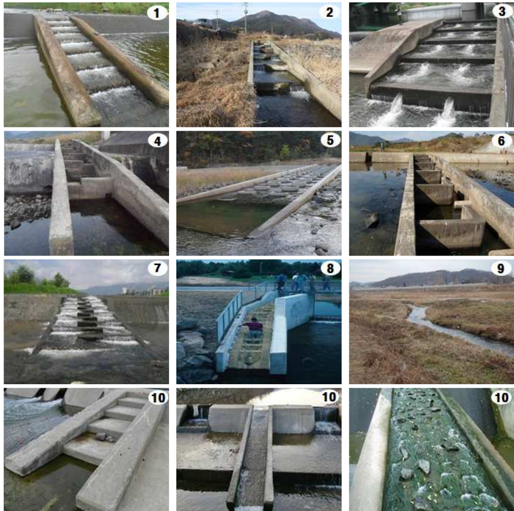
〈그림 2-1〉 하천설계 기준에 따른 어도 형식
