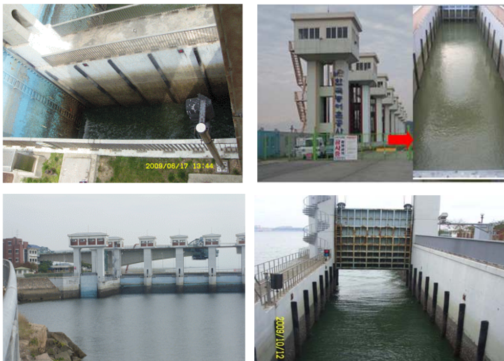
〈그림 30〉 배수갑문에 설치된 갑문식 어도(홍보방조제, 영산호, 영암호, 금호호)
