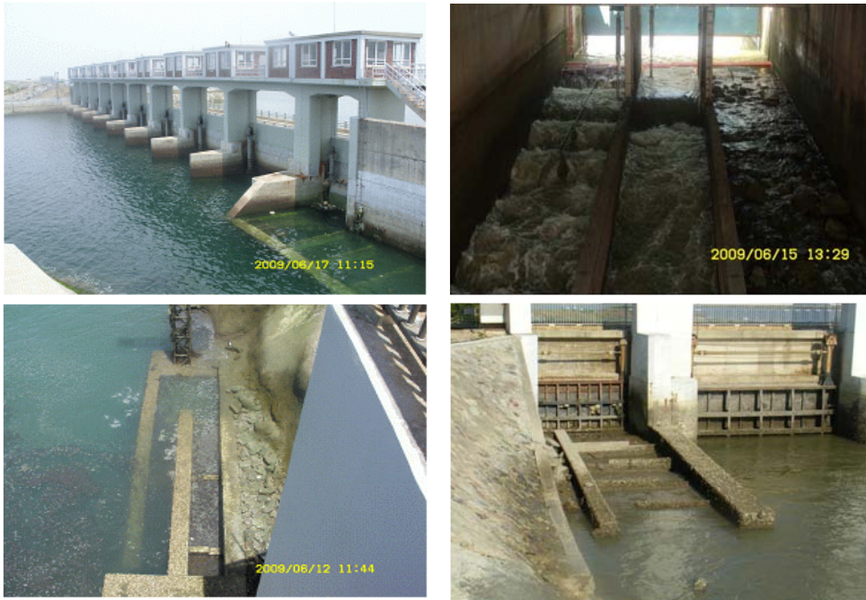
〈그림 7-1〉 배수갑문에 설치된 계단식 어도(부사방조제, 금강하구둑, 이원호, 고천암호)
