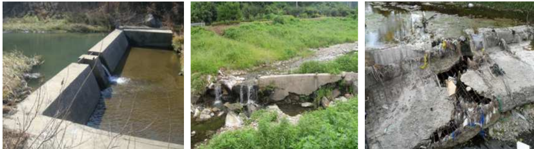
〈그림 31〉 어도 설치를 위한 보 상태 조사(좌 : 양호, 중 : 보통, 우 : 불량)
