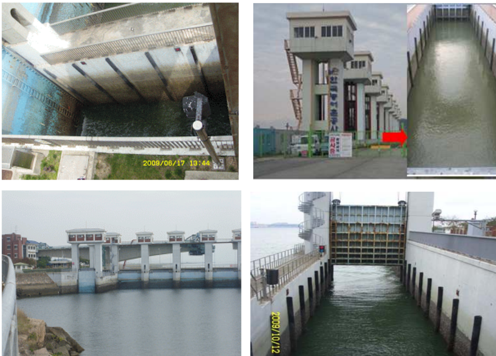
〈그림 7-2〉 배수갑문에 설치된 갑문식 어도(홍보방조제, 영산호, 영암호, 금호호)
