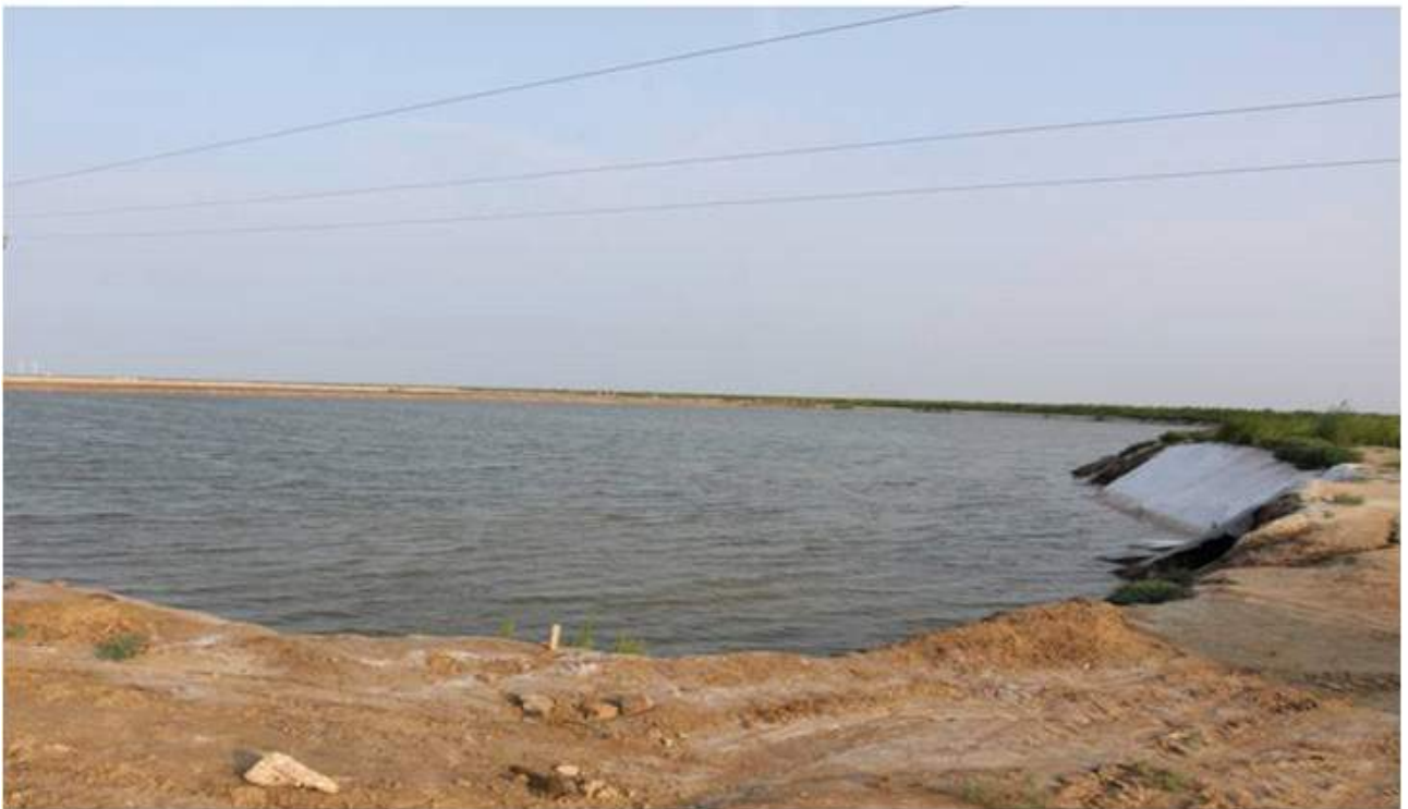
그림 21. 중국 현지 실험 해수취수 후 1차 침전조 및 사육수 보충수 수조
