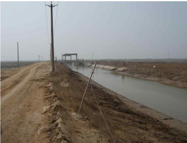
그림 84. 주수 및 배수로 시설
