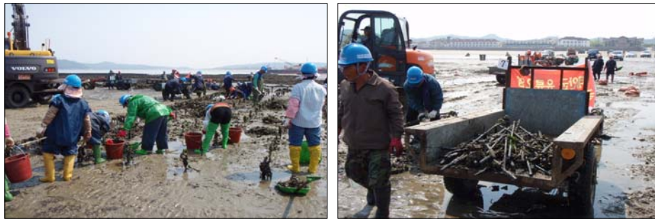
[그림 4] 말뚝 제거 및 운반작업 - 굴채묘 양식장(간조 시)
